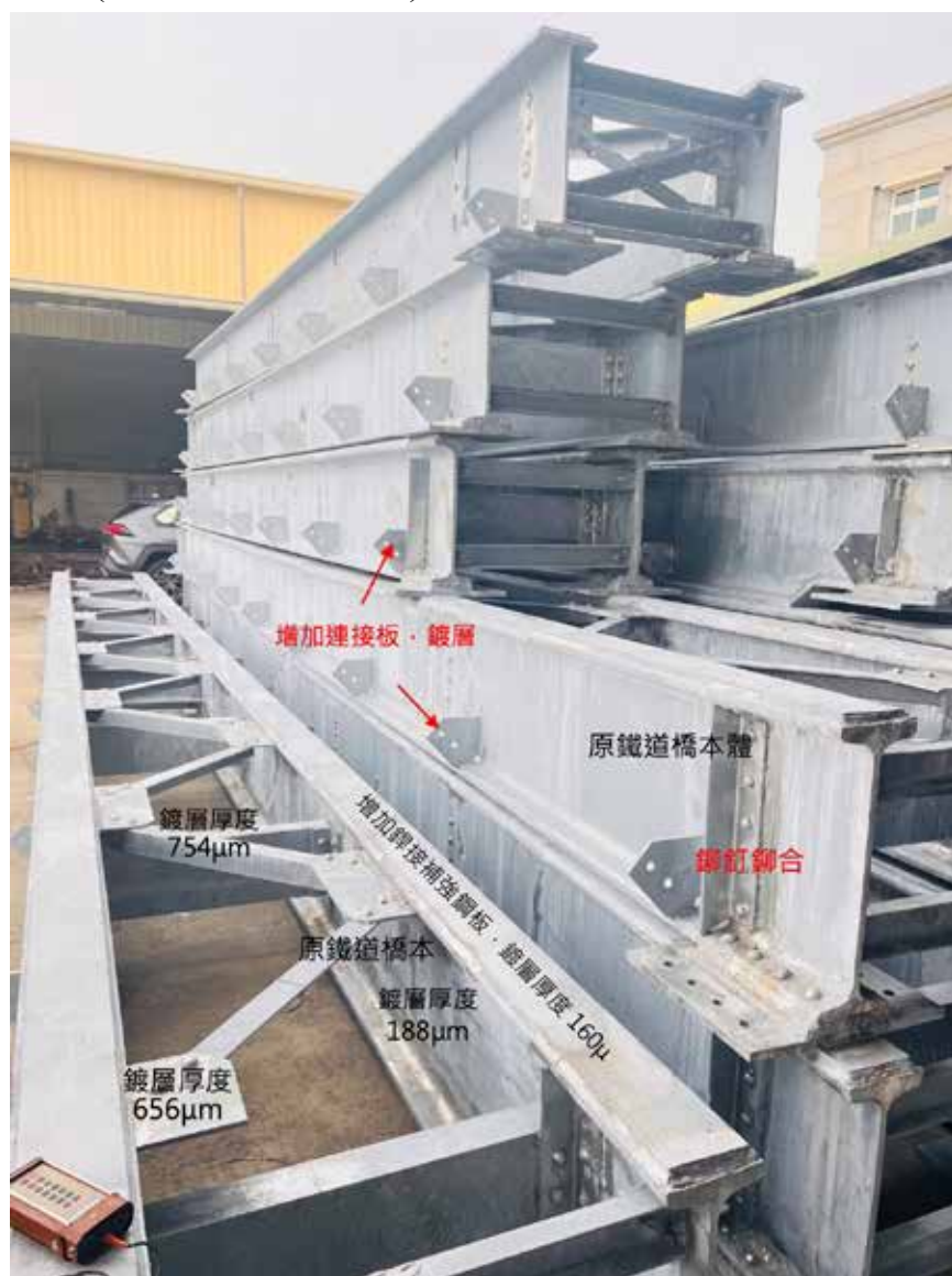
圖 9 原鐵道橋鉚合鋼 I 梁本體鍍鋅後外觀
