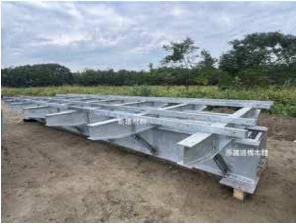
圖 6 新增材料與原鐵道橋本體組合
