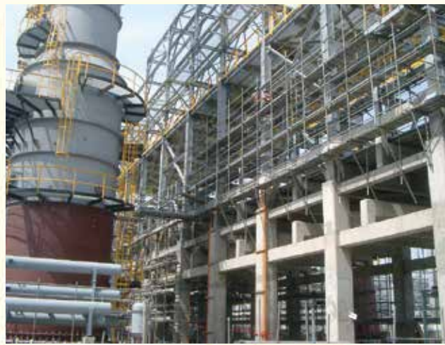
中油林園新六輕廠房結構
