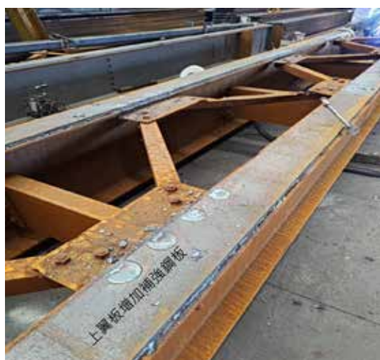
圖 5 鋼梁局部銲接補強（未鍍鋅）
