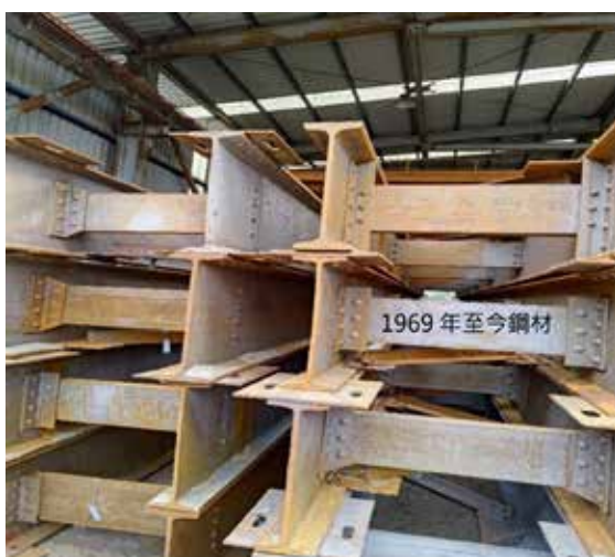
圖 4 鋼 I 梁鉚釘組合（已噴砂）
