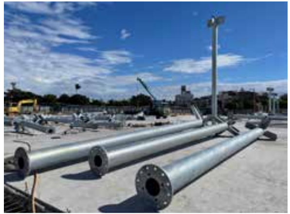
圖 2 熱浸鍍鋅圓管柱 ( \text{Ø}406\text{mm}\times 5\sim 11\text{m} )
