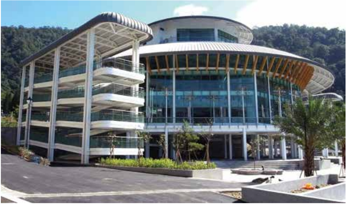
日月潭纜車鋼結構
