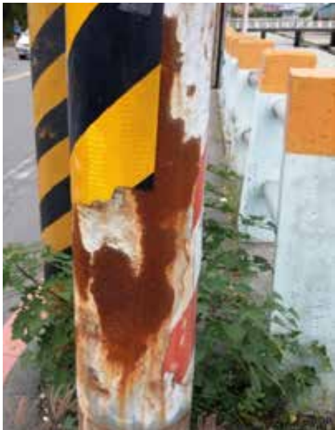
圖 3 泰山中港西路燈電桿反光紙表面受到破損後之腐蝕狀況
