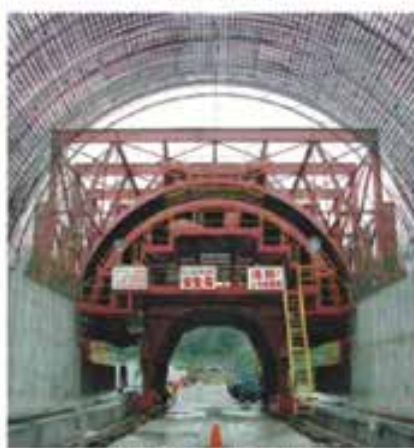
高鐵隧道內外鋼模台車
