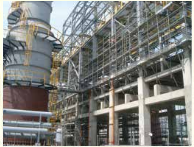
中油林園新六輕廠房結構
