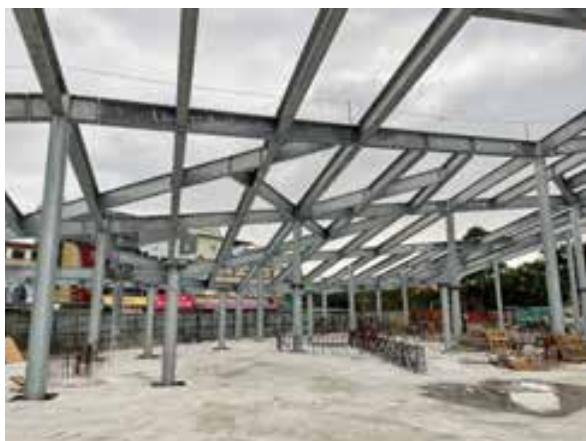
圖 5 鋼結構，經熱浸鍍鋅防蝕處理
