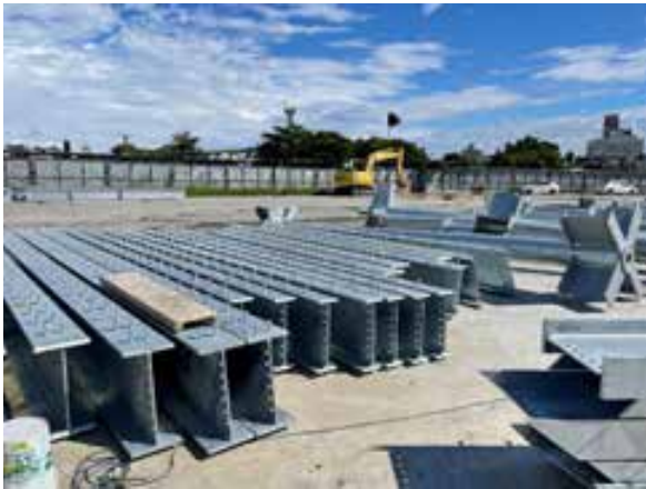
圖 1 熱浸鍍鋅 H 鋼橫梁 ( 600\times 300\times 4.5\text{m}\sim 15\text{m} )
