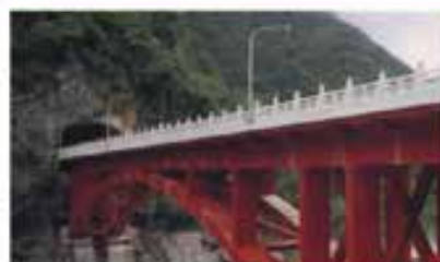
太魯閣砂卡槽溪鐵橋
