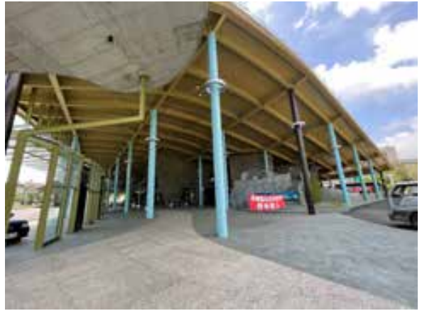
圖 8 轉運站雨庇 (熱浸鍍鋅後+防火漆)
