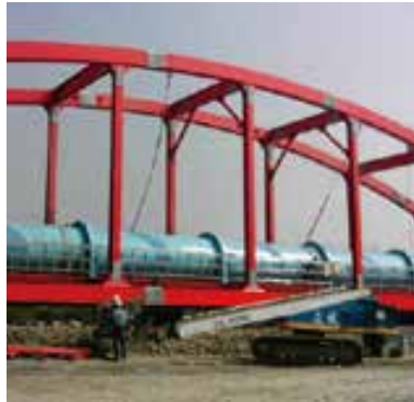
台中大肚溪水管橋
