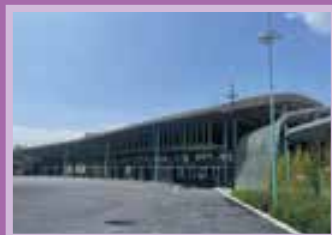
宜蘭轉運站新建工程
