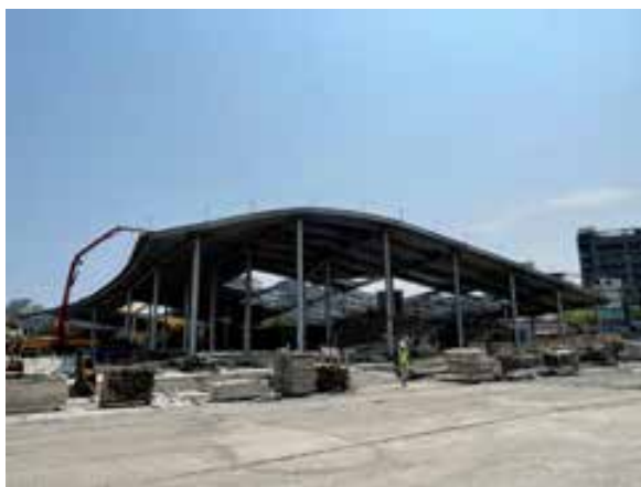
圖 6 屋頂吊裝作業
