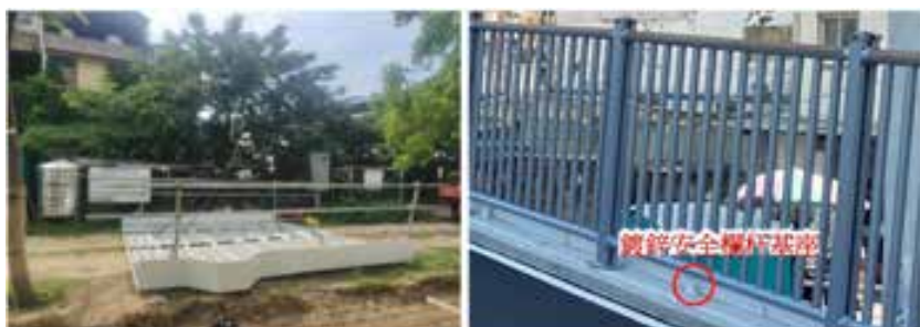
圖 7 SC Deck 安全欄杆先行及欄杆底座
