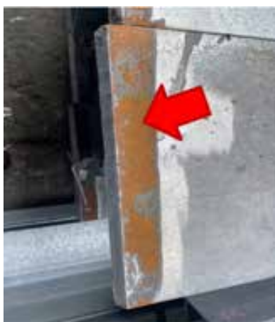
圖 1 鋼構件不鍍面處理
