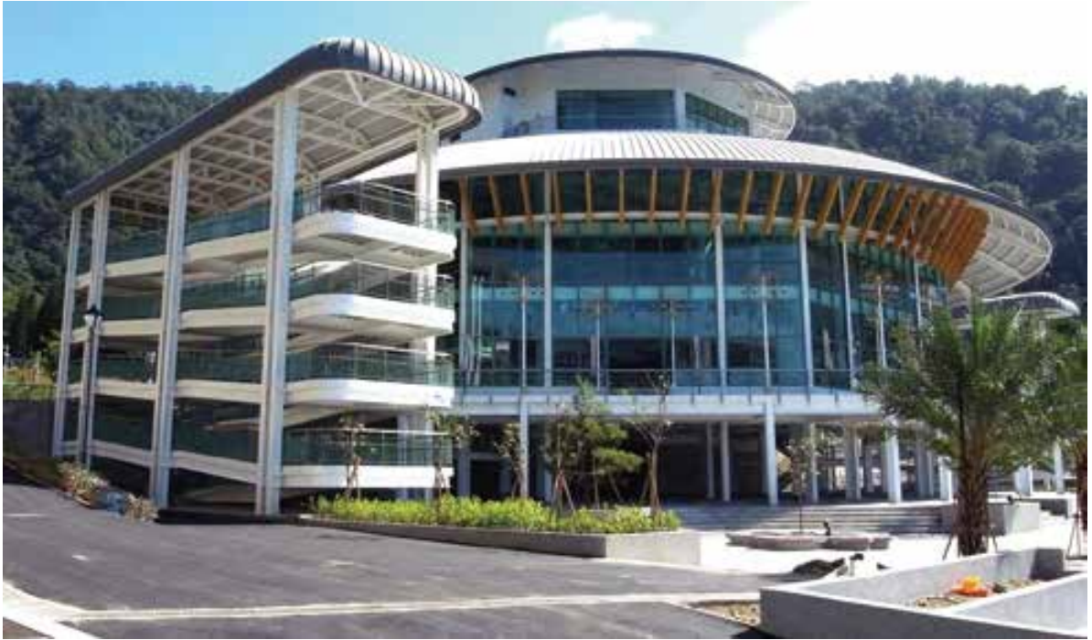
日月潭纜車鋼結構
