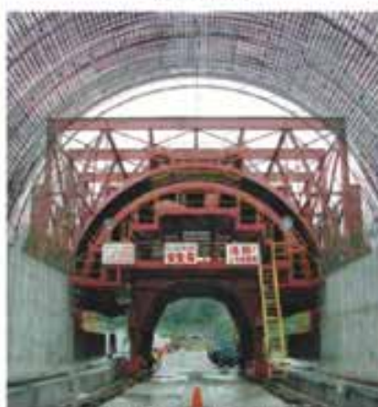
高鐵隧道內外鋼模台車
