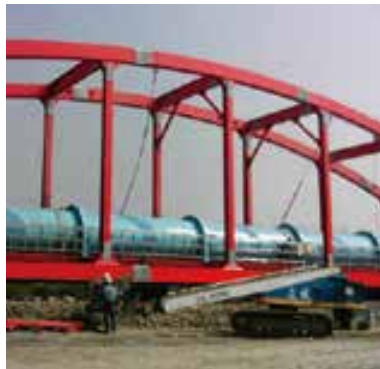
台中大肚溪水管橋
