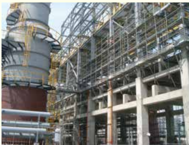
中油林園新六輕廠房結構
