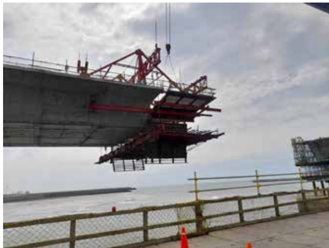
圖 9 懸臂柱頭節塊施工情況
