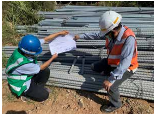
(b) 鋼筋取樣
