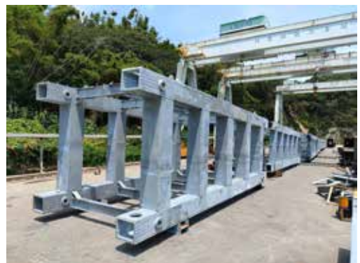
圖 6 鋼構廠預組立 (一)
