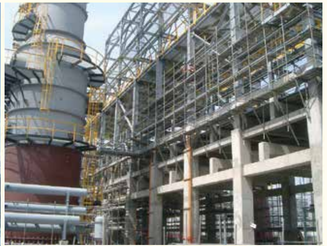
中油林園新六輕廠房結構
