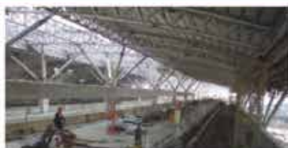
高鐵車站天花板
