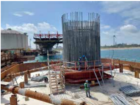
(a) 橋柱基礎版鍍鋅鋼筋綁紮
