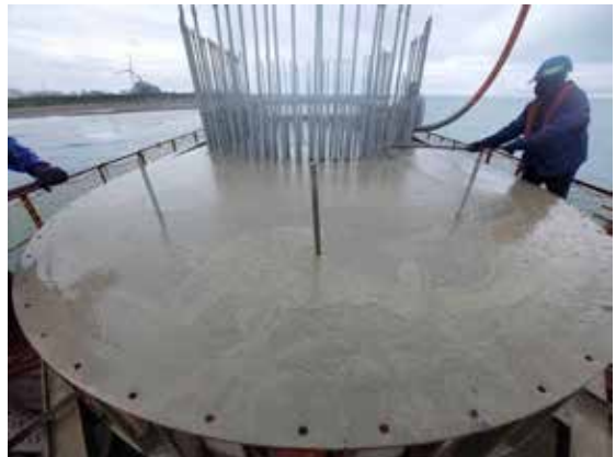
(b) 鋼模組立後完成混凝土澆置
