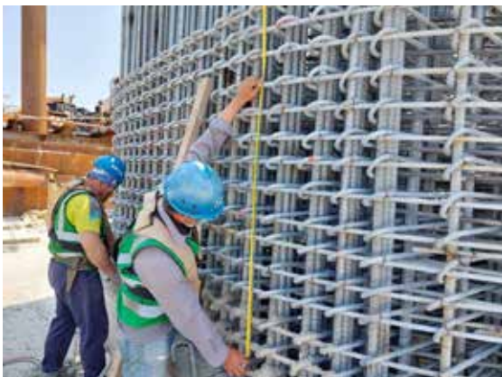
圖 14 鋼筋間距查驗
