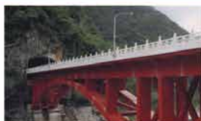
太魯閣砂卡礑溪鐵橋
