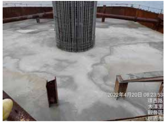
(b) 鋼模組立後完成混凝土澆置
