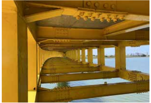
圖 12 螺栓採用 A325 高強度熱浸鍍鋅螺栓 (二)
