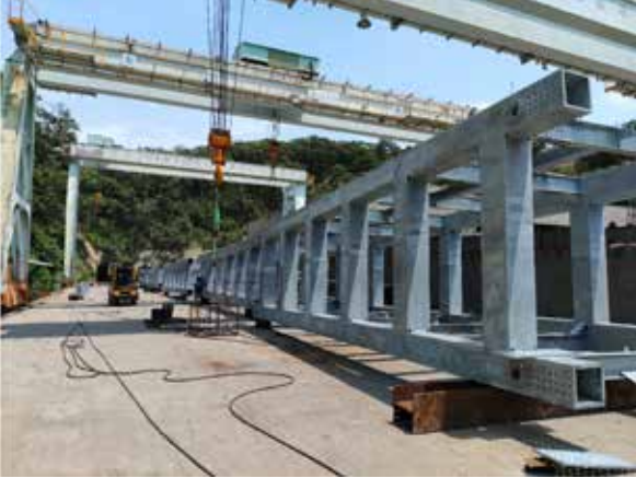
圖 7 鋼構廠預組立 (二)
