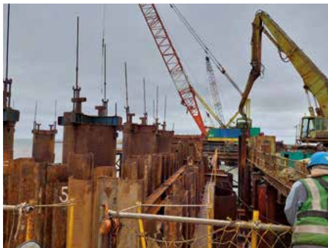
圖 7 全套管基樁施工
