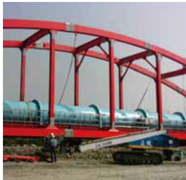
台中大肚溪水管橋
