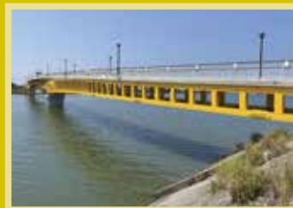
鳳山溪水月意象景觀橋工程
