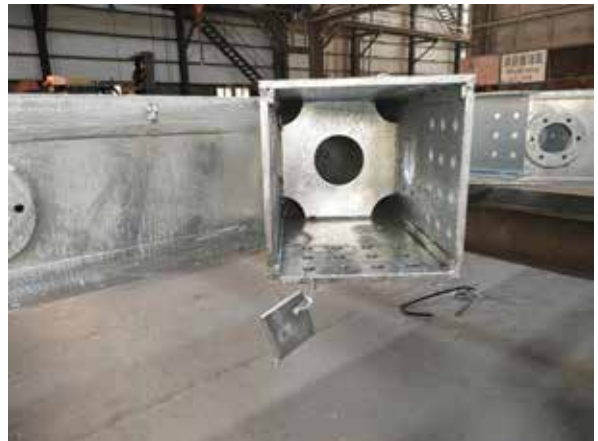
圖 4 熱浸鍍鋅整理作業，吊掛試片為後 續送實驗室檢驗用
