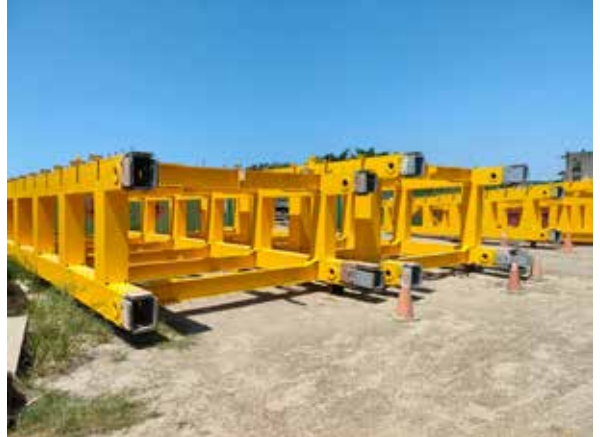
圖 8 油漆塗裝完成後運送至工地
