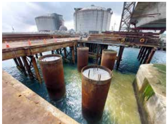
圖 15 全套管基樁施工
