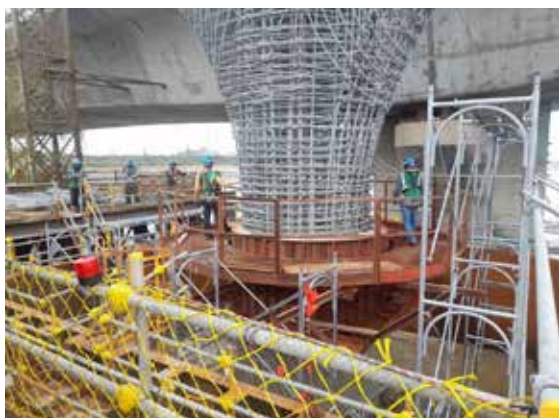
圖 16 橋柱樁帽鍍鋅鋼筋綁紮
