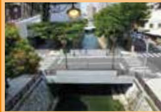
110年度臺中市南區綠川排水-濟世綠橋梁改建應急工程
