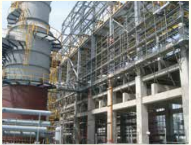
中油林園新六輕廠房結構
