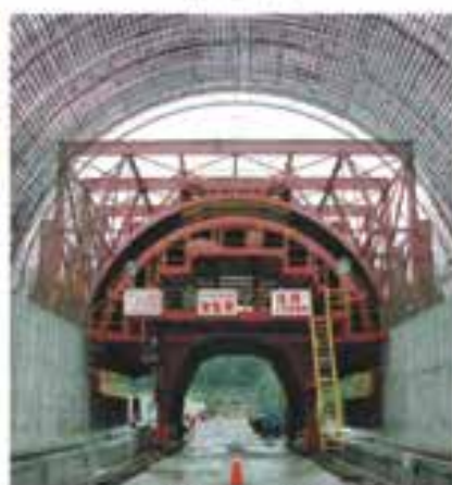
高鐵隧道內外鋼模台車
