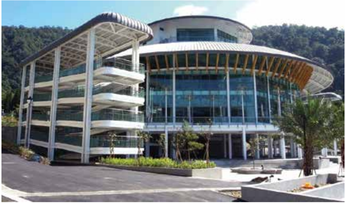
日月潭纜車鋼結構
