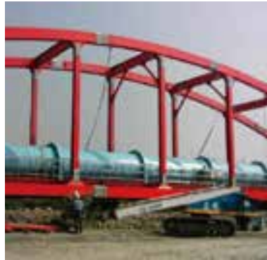
台中大肚溪水管橋
