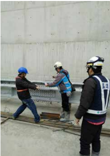
圖 9 螺栓扭力測試
