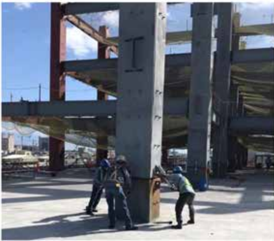
圖 10 鋼構柱吊裝續接
