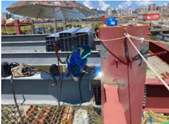
圖 14 鋼構梁銲接
