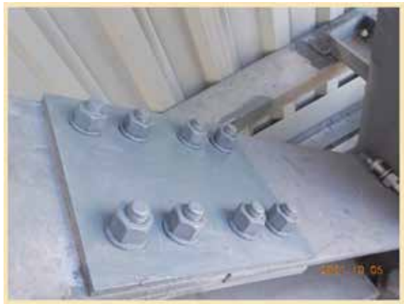
圖 31 高強度螺栓高鋅漆修復
