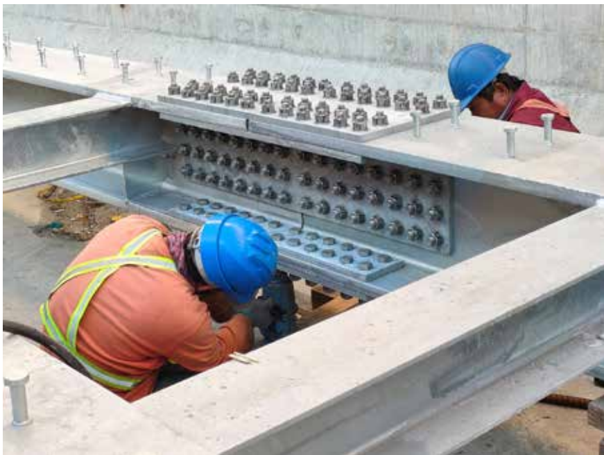
圖 7 工地安裝 - 螺栓採用 A325 高張力熱浸鍍鋅螺栓
