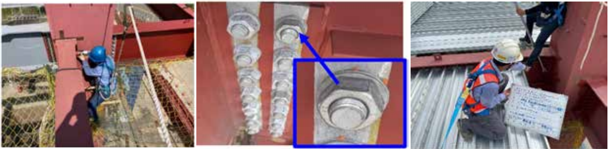
圖 8 螺栓現場鎖固及查驗
