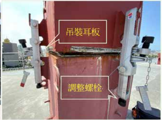
圖 11 ACE-UP 夾具鎖固
