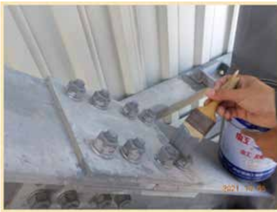
圖 31 高強度螺栓高鋅漆修復
