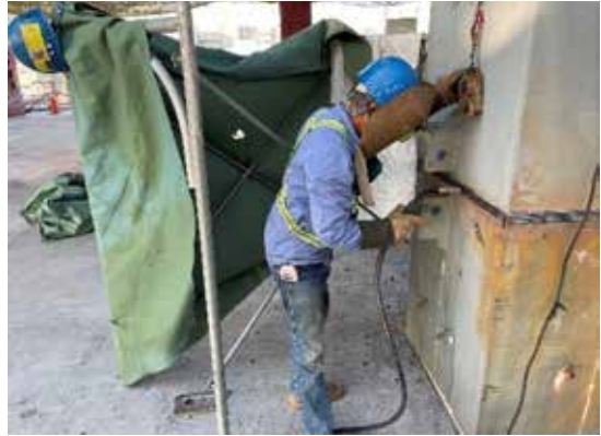
圖 13 鋼構柱銲接
