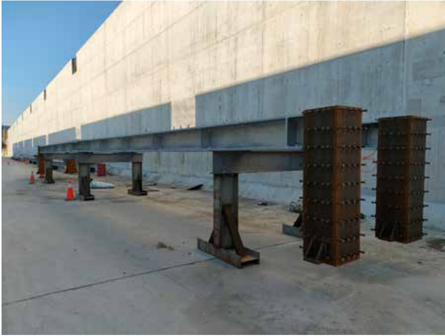
圖 11 工地一隅，因箱型梁為水泥灌漿，故不熱浸鍍鋅
