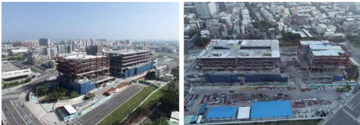
圖 16 2022/1/30 工地施工現況照片
