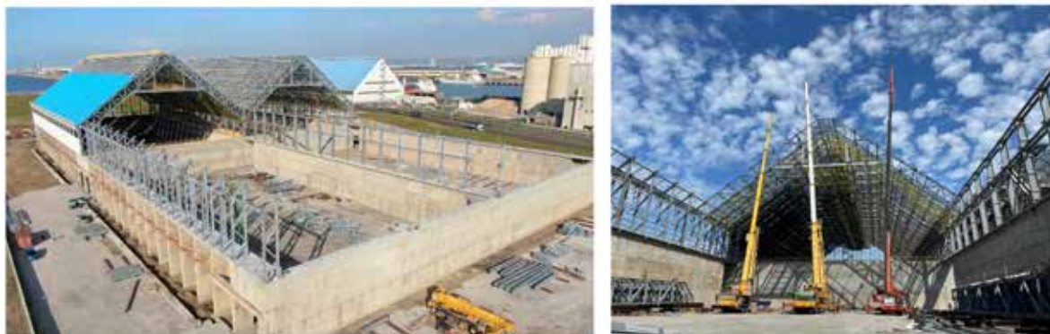
圖 17 煤倉主體鋼構工程
