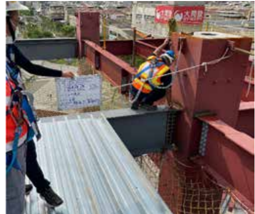
圖 15 鋼構梁銲接 UT 檢測
