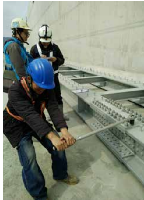
圖 10 螺栓扭力測試
