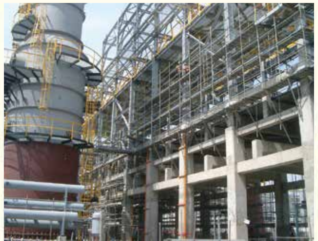
中油林園新六輕廠房結構
