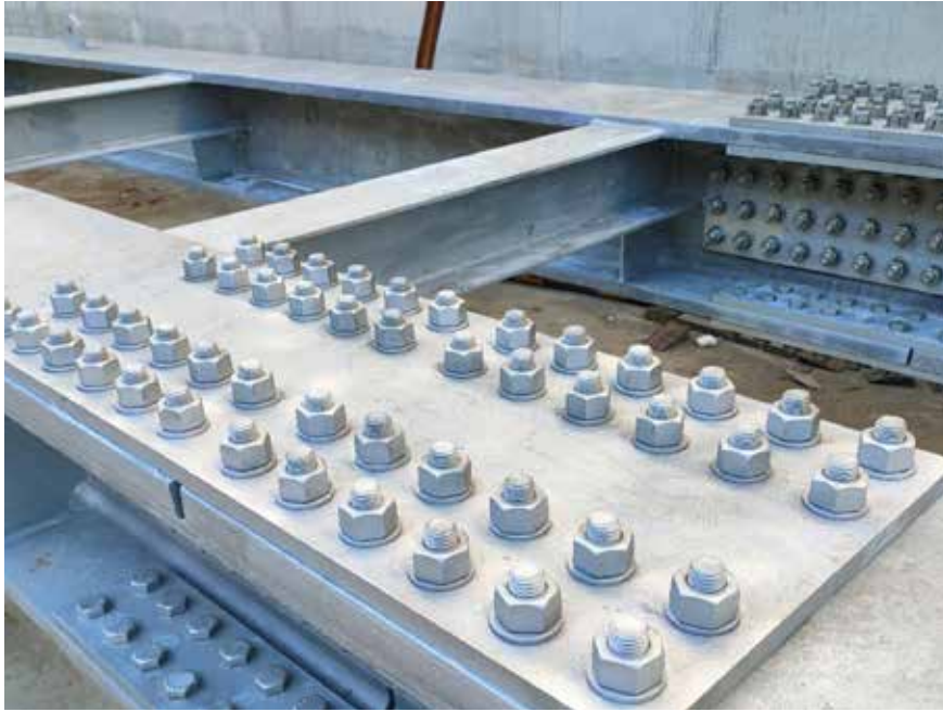
圖 8 A325 高張力熱浸鍍鋅螺栓
