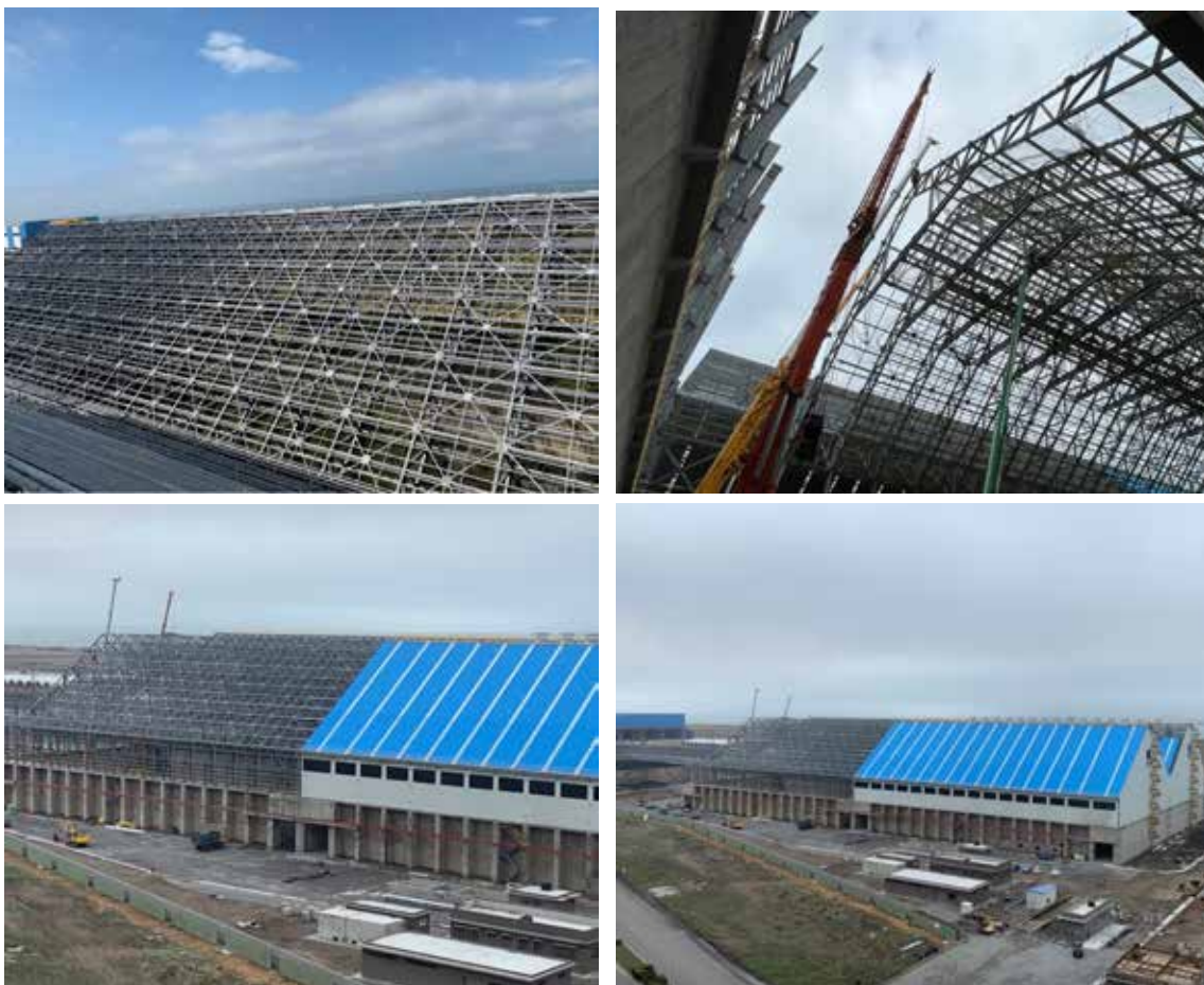
圖 32 2022/2/18 工地施工現況照片
