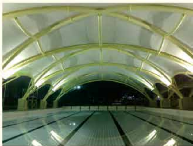
屏東科技大學游泳池
