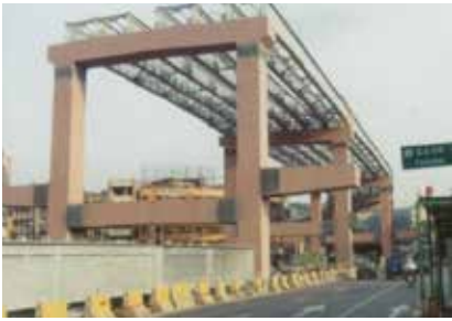
照片 3. 中和交流道上構熱浸鍍鋅 I 型鋼梁 [2]
