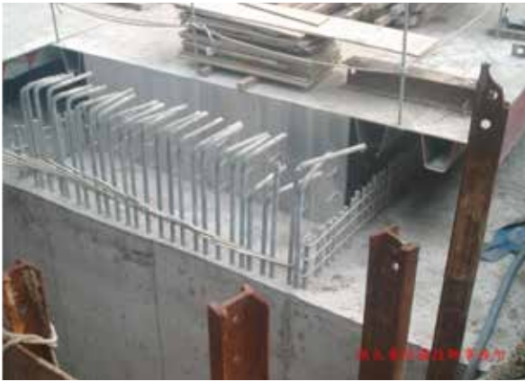
照片 18. 熱浸鍍鋅鋼筋橋台 [6]
