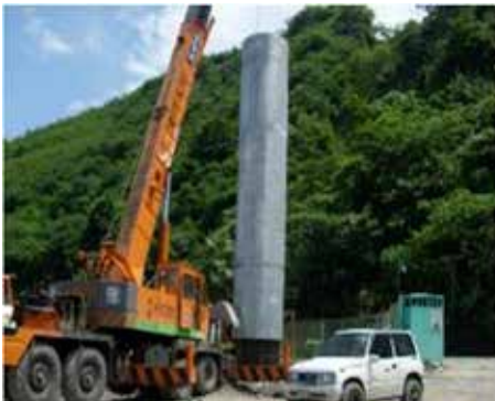
照片 6. 柱體以熱浸鍍鋅鋼板圍束 [2]
