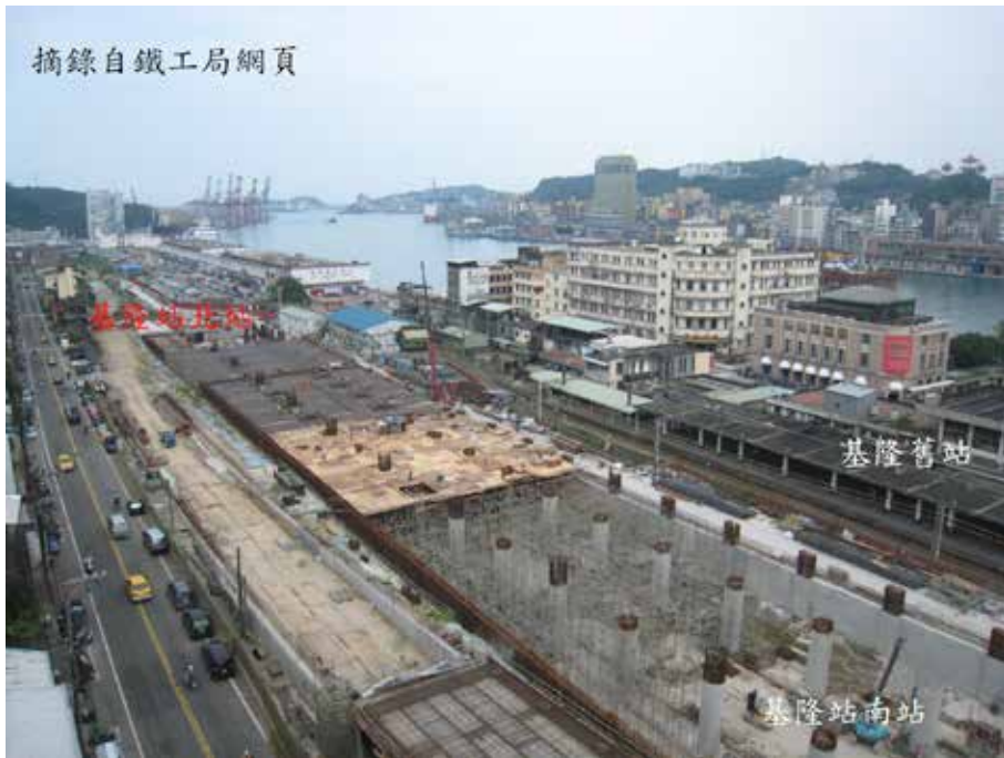
圖四 站體基礎完成
