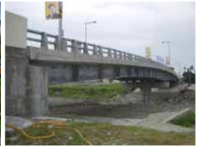
照片 5. 中壇橋採熱浸鍍鋅 I 型梁 [2]
