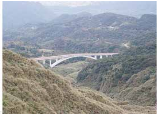
照片 2. 馬槽橋外觀 [3]
