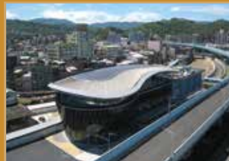
基隆火車站主體鋼鐵工程
