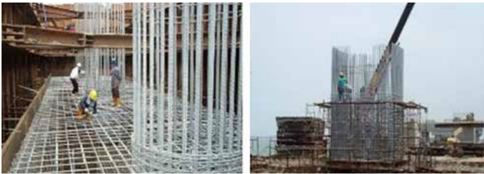
照片 11. 台 61 線快速公路崙尾灣基礎與墩柱採熱浸鍍鋅鋼筋 [2]
