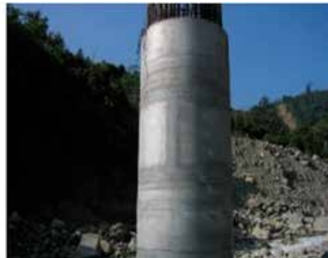
照片 7. 柱體以熱浸鍍鋅鋼板圍束 [2]
