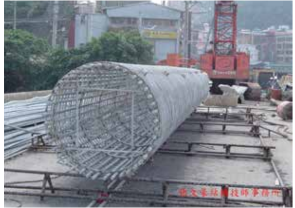
照片 15. 熱浸鍍鋅鋼筋籠 (基樁用) [6]
