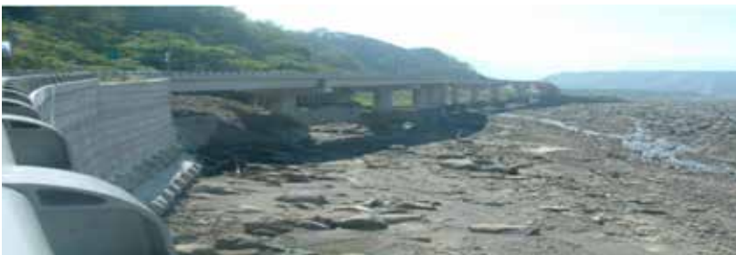
照片 6. 柱體以熱浸鍍鋅鋼板圍束 [2]
