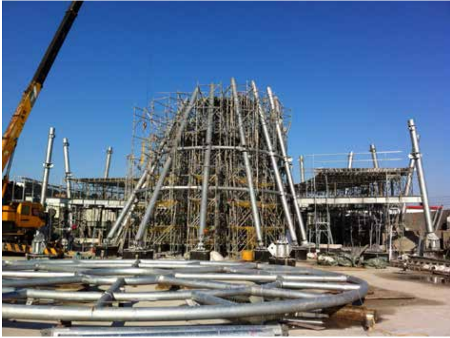
圖八 北站站體熱浸鍍鋅鋼架吊裝
