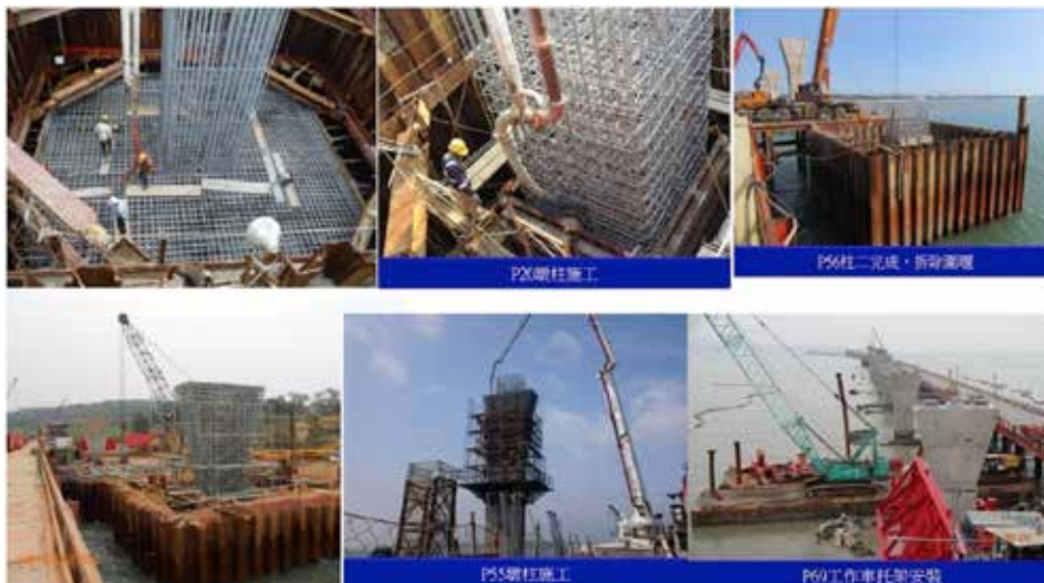
照片 22. 邊橋及引橋墩柱施工 (採熱浸鍍鋅鋼筋)
