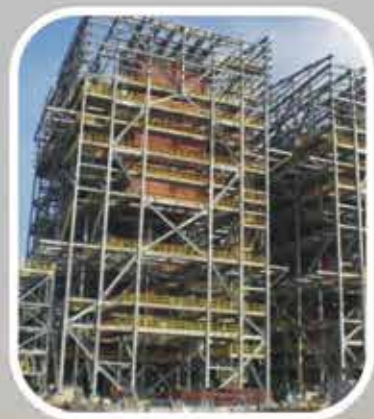
台塑德州案鍋爐鋼構工程
