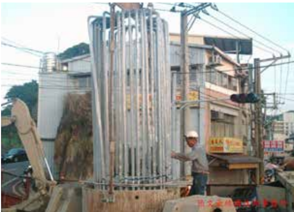
照片 16. 熱浸鍍鋅鋼筋橋台基樁 [6]
