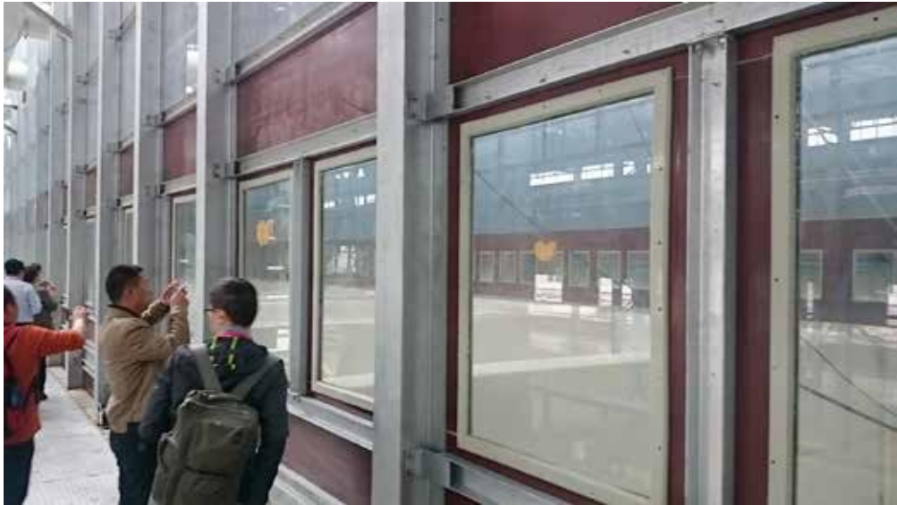
江蘇國強鍍鋅實業公司新設前處理區為全罩式
