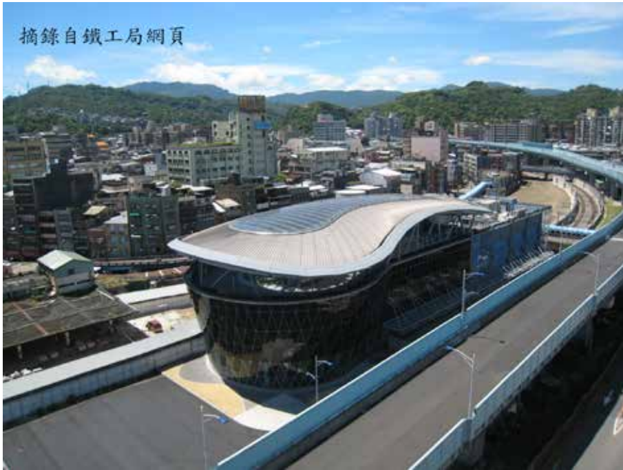
圖十二 南站外牆以玻璃帷幕搭配金屬板，並於屋頂裝置太陽能板節能減碳
