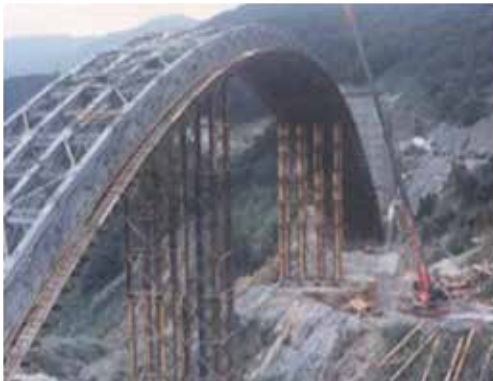
照片 1. 熱浸鍍鋅鋼箱梁拱架結構施工 [2]
