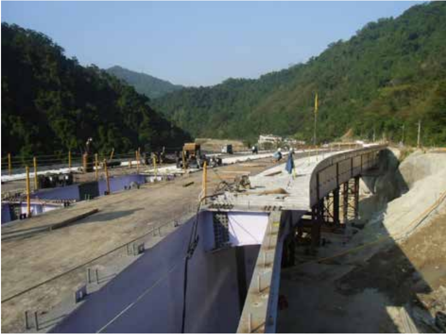
圖 9. 鋪設熱浸鍍鋅免拆鋼模板
