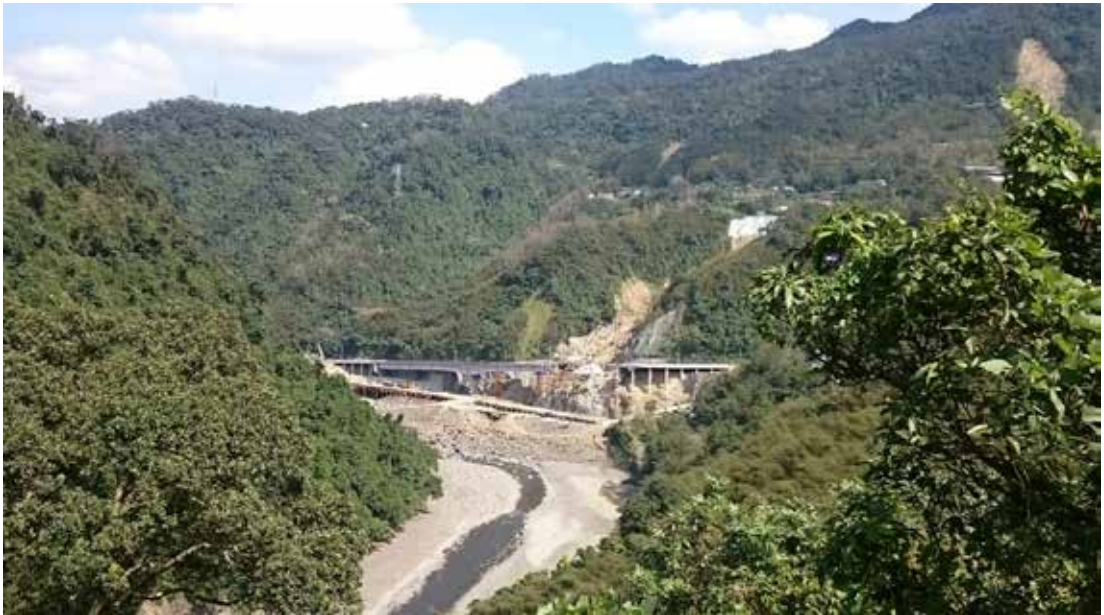
圖 2. 建設大跨距橋梁跨越土石流沖蝕區
