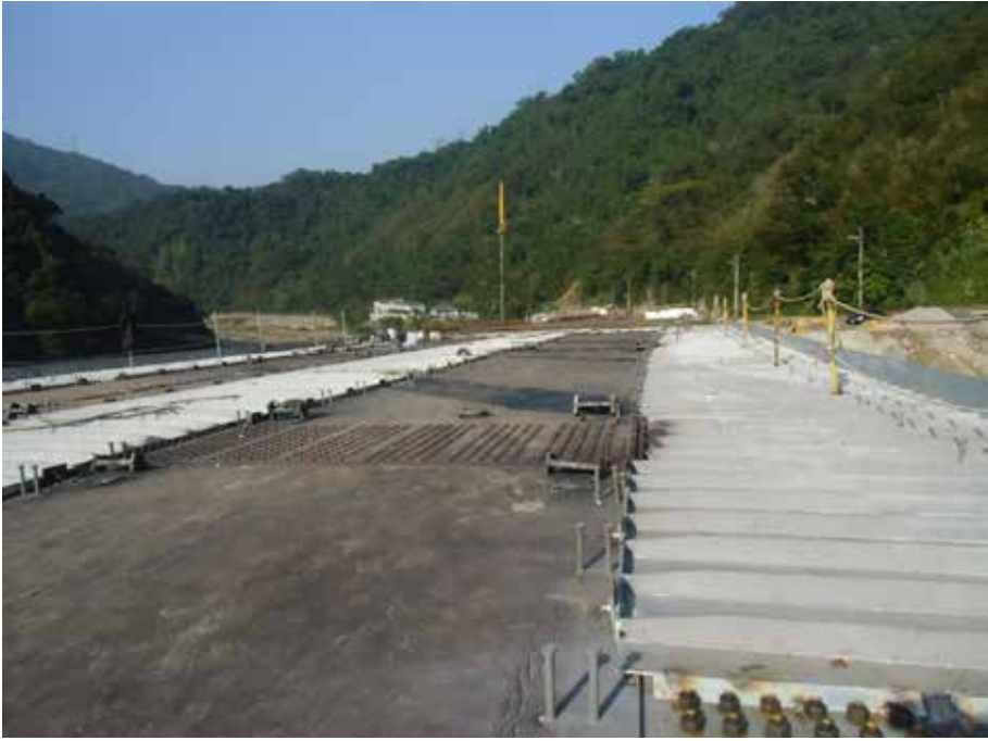
圖 11. 熱浸鍍鋅免拆鋼模板完成
