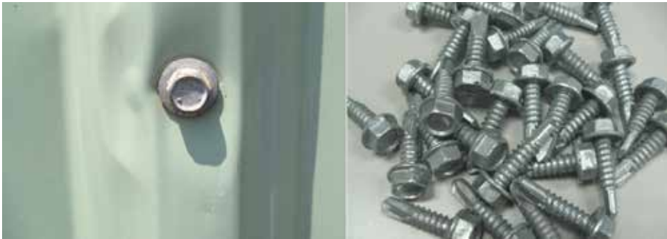
圖 9. 鍍鋅彩色鋼板採用熱浸鍍鋅自攻螺絲 (左) 及鍍鋅自攻螺絲 (右)
