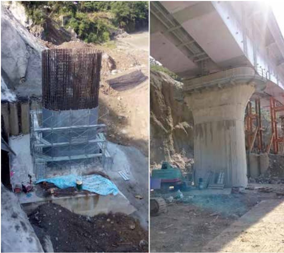
圖 4. 橋墩包覆鍍鋅防撞鋼板
