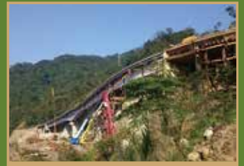
台9甲10k+200段災害修復工程- 熱浸鍍鋅免拆鋼模板
