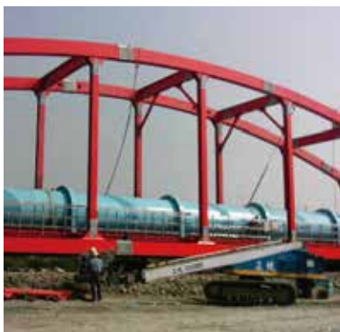
台中大肚溪水管橋
