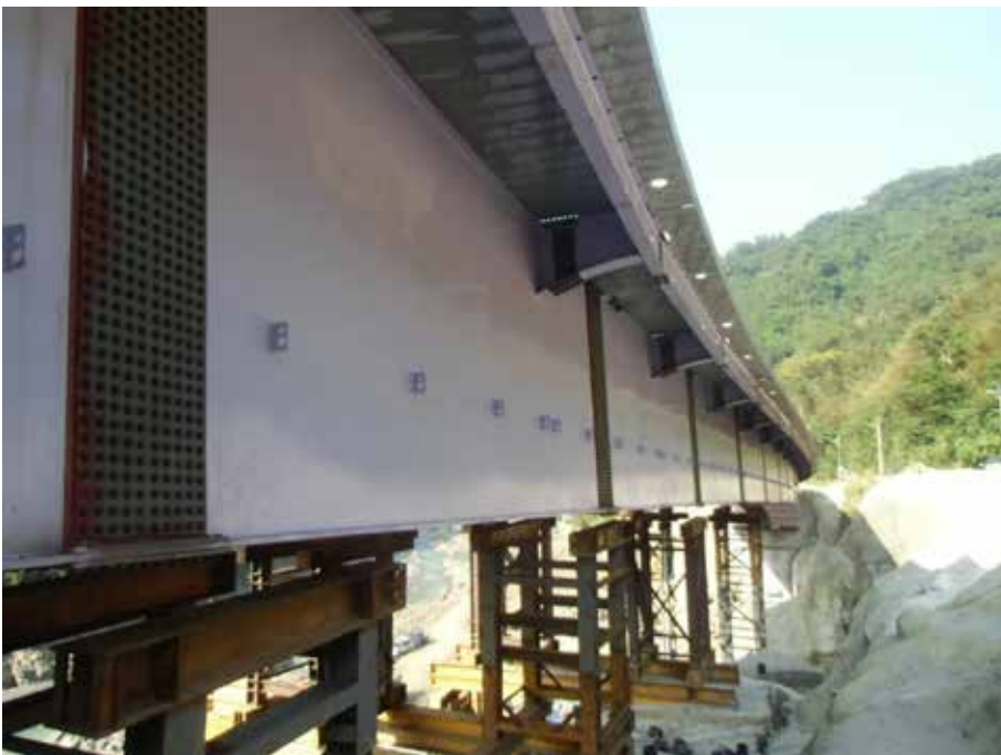
圖 10. 箱梁外側鋪設免拆鋼模板情形
