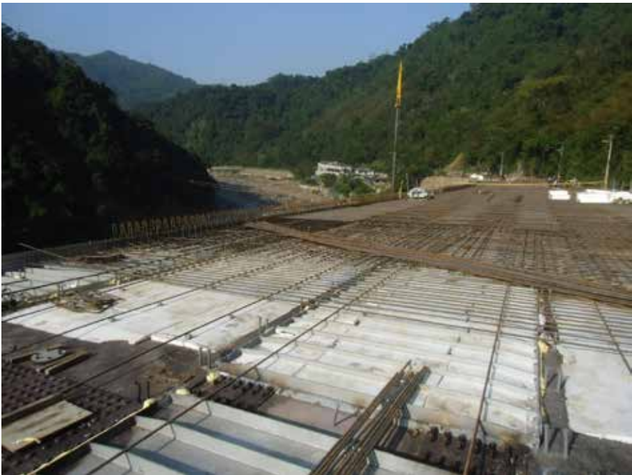
圖 12. 配置鋼筋於免拆鋼模板上
