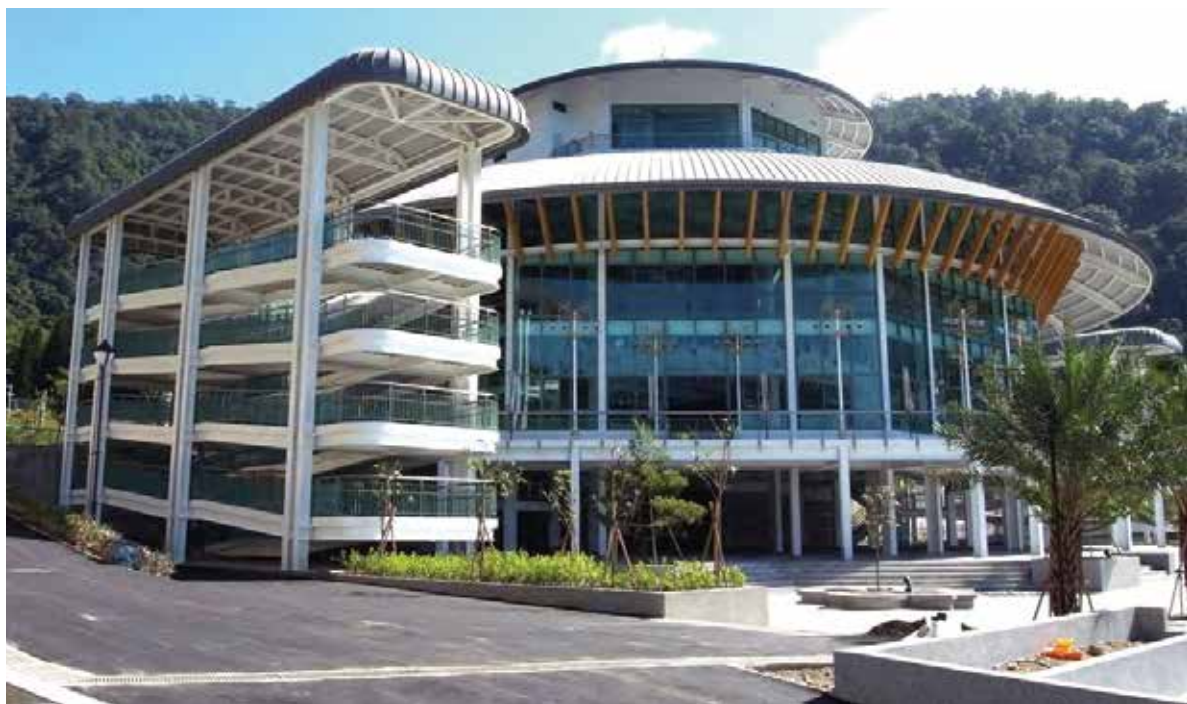
日月潭纜車鋼結構
