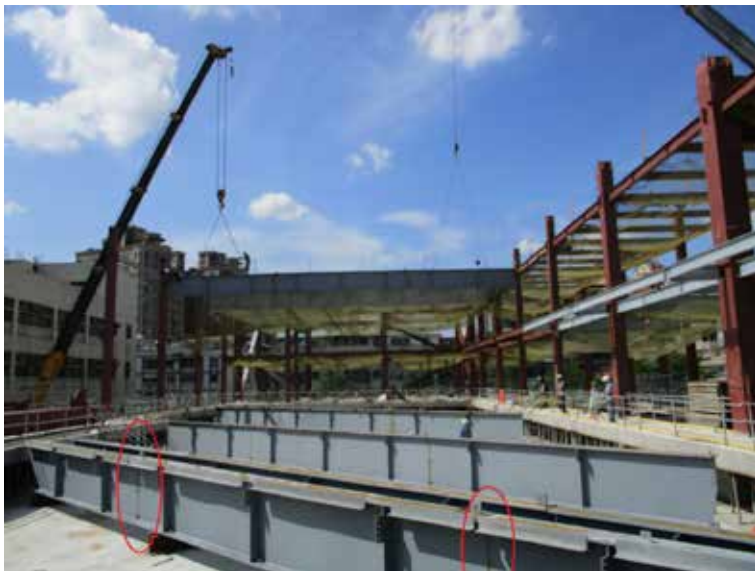
圖 5. 銲接處再塗覆環氧樹脂漆 (紅圈處)
