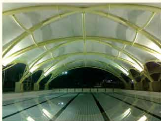
屏東科技大學游泳池
