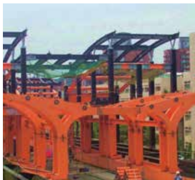
台北捷運內湖車站
