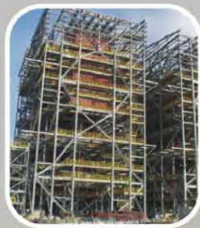
台塑德州案鍋爐鋼構工程
