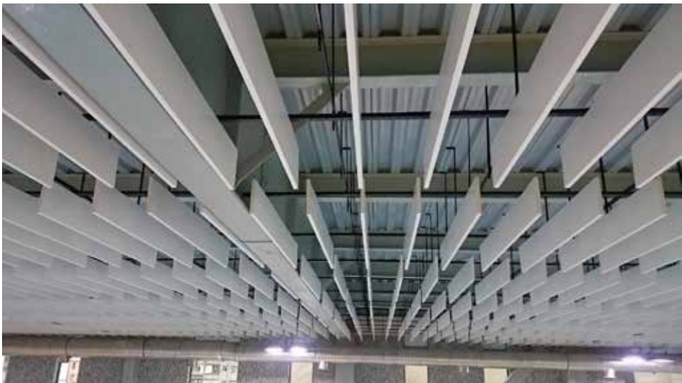
圖 7. 游泳池屋頂、橫梁採熱浸鍍鋅處理
