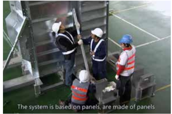
圖 3. 熱浸鍍鋅鋼板組裝 1
