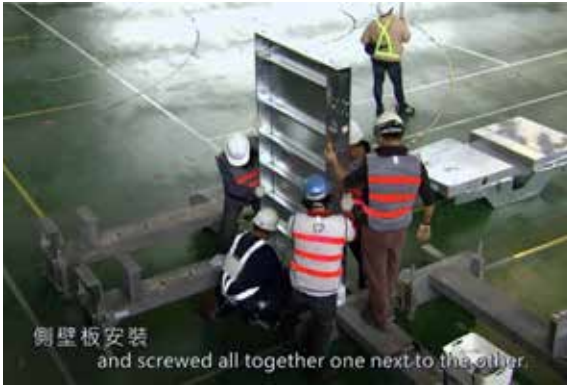
圖 2. 熱浸鍍鋅鋼板與基座組裝
