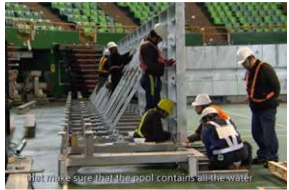
圖 5. 熱浸鍍鋅鋼板組裝 3
