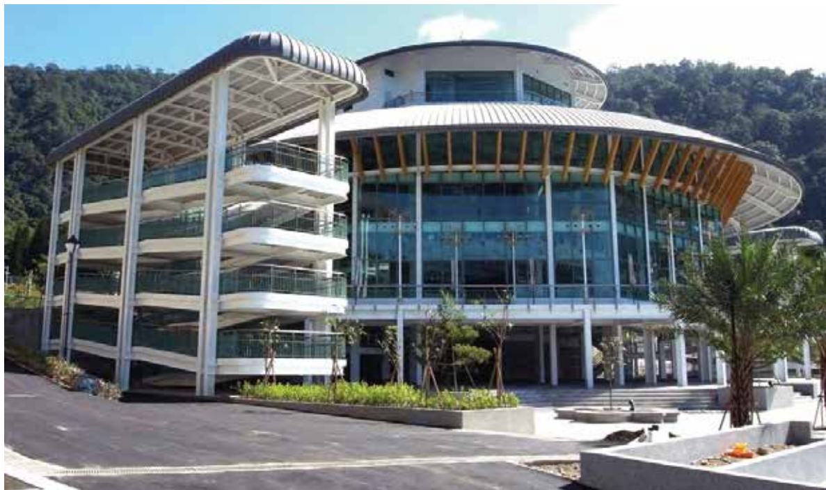
日月潭纜車鋼結構
