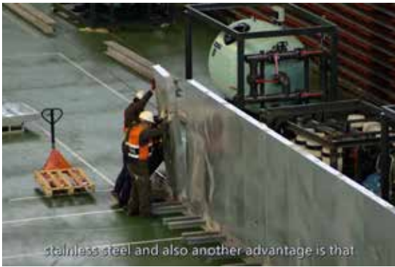
圖 4. 熱浸鍍鋅鋼板組裝 2
