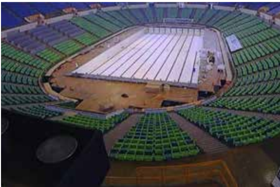
圖 12. 活動式游泳池周邊地板鋪設
