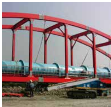
台中大肚溪水管橋
