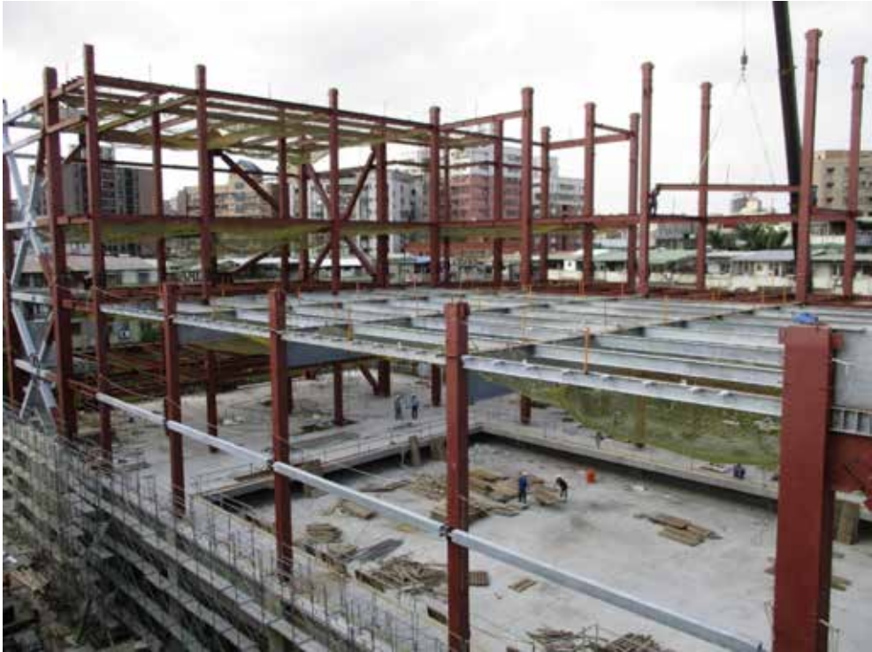
圖 6. 游泳池屋頂以及周圍橫梁採熱浸鍍鋅處理
