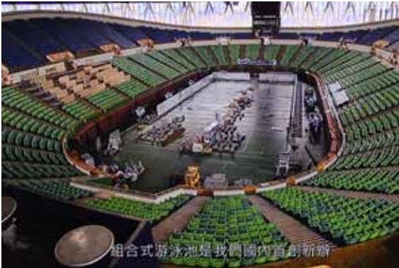
圖 6. 熱浸鍍鋅鋼板組裝 4
