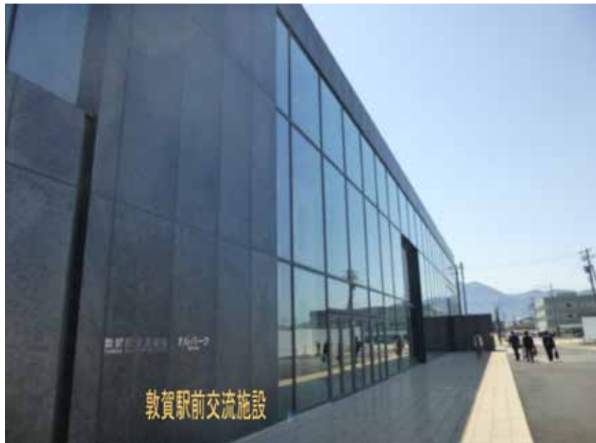
圖 3. 低光澤磷酸鋅處理使用例
