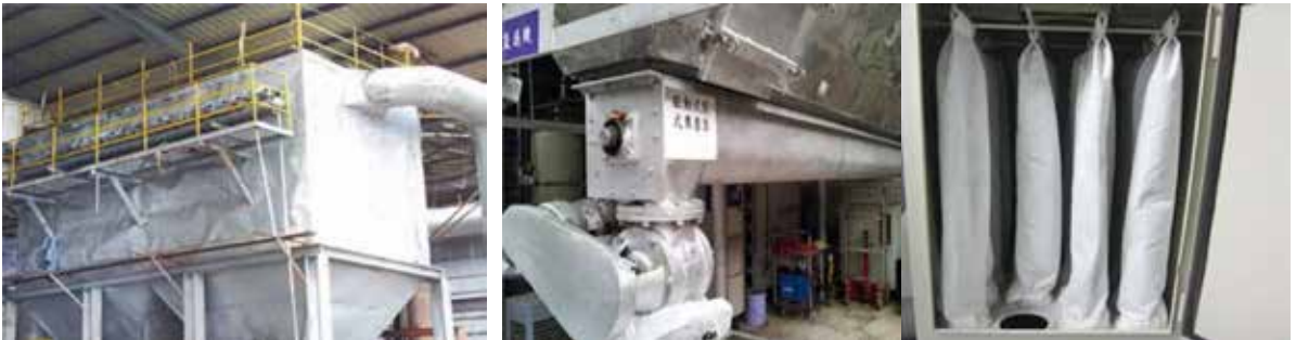
相片 2-1. 袋式集塵器設備外觀 相片 2-2. 螺旋輸送器 + 旋轉下料閥 相片 2-3. 濾袋
