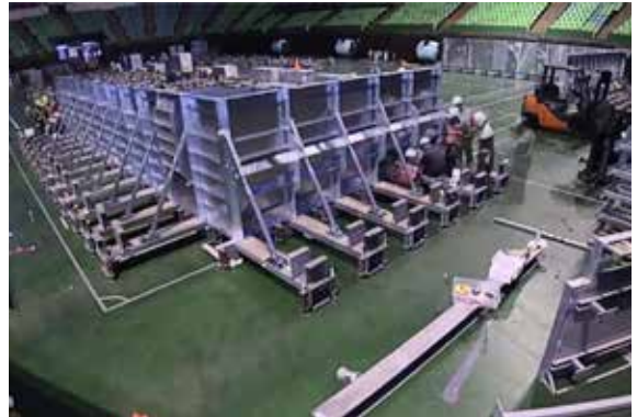
圖 7. 熱浸鍍鋅鋼板組裝 5
