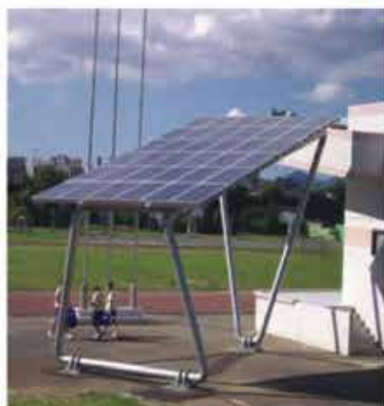
板橋國中太陽光電結構
