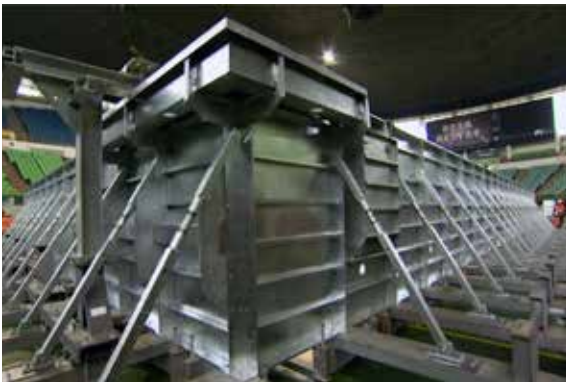
圖 8. 活動式游泳池熱浸鍍鋅鋼板外觀
