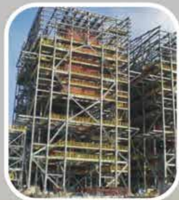
台塑德州案鍋爐鋼構工程
