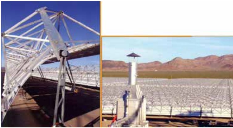
圖 2、美國內華達太陽能跨越超過 400 英畝的電腦控制反光鏡，經 80,000 個鏡面板產生 64 MW 的電力 (2)
