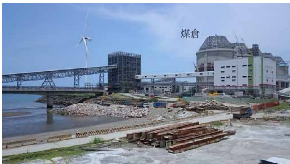
圖 5、轉送塔至煤倉 (屋頂鋼構經熱浸鍍鋅處理)
