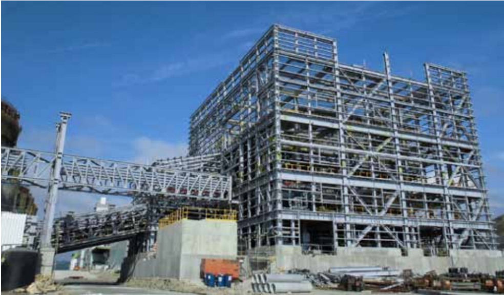
圖 6、轉送塔 (鋼構經熱浸鍍鋅處理)
