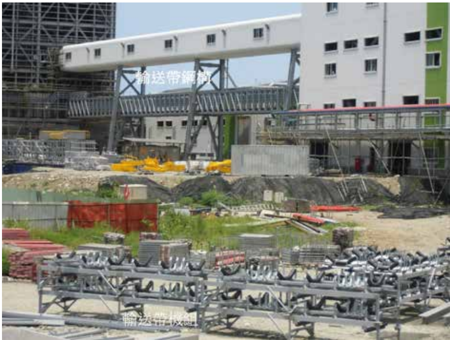
圖 10、輸送帶（機組鋼構經熱浸鍍鋅處理）
