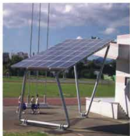
板橋國中太陽光電結構
