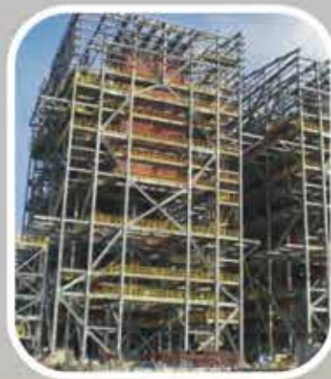
台塑德州案鍋爐鋼構工程
