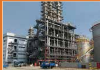
台合石化林園廠汽電共生廠
