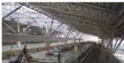
高鐵車站天花板
