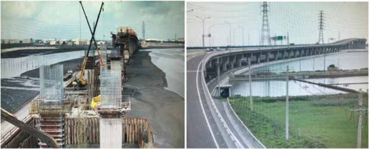
台 61 西濱快速公路崙尾灣橋工程施工 (7)
