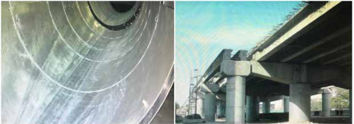
國道 2 號拓寬工程熱浸鍍鋅補強鋼板 (8)
