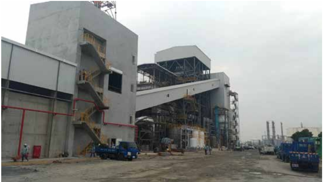
圖 2、鍋爐島鋼構工程暨 IPHO 製程區鋼構工程現場～外觀一
