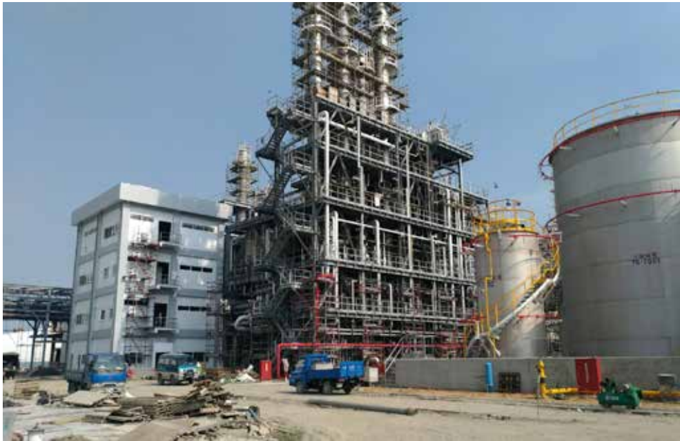
圖 3、鍋爐島鋼構工程暨 IPHO 製程區鋼構工程現場～外觀二
