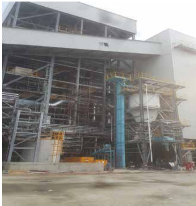
圖 4、鍋爐島鋼構工程暨 IPHO 製程區完成外貌(摘錄自台灣石化合成股份有限公司網站)
