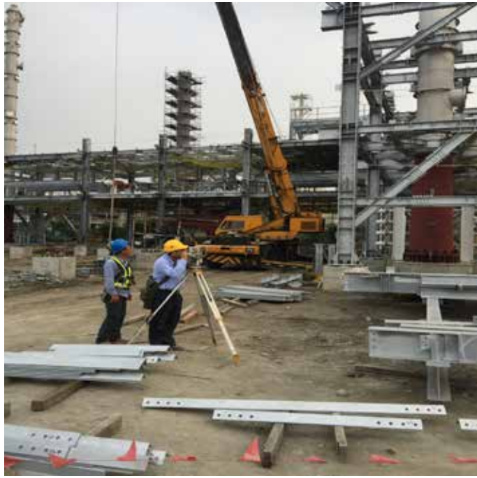
圖 1、鍋爐島鋼構工程暨 IPHO 製程區鋼構工程現場丈量作業
