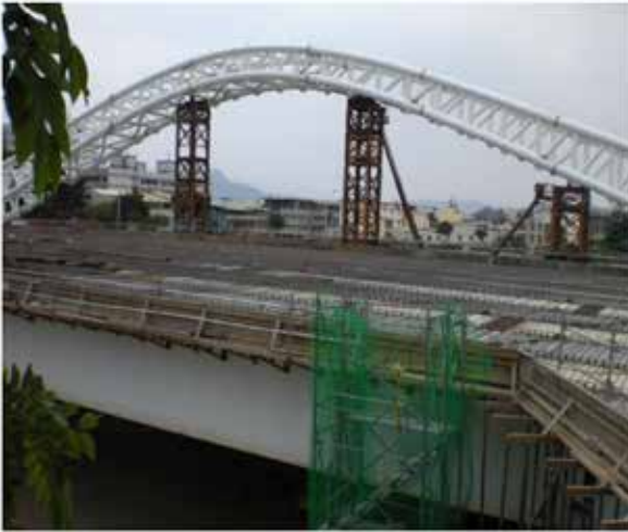
松竹五路～海天橋工程施工 (9)
