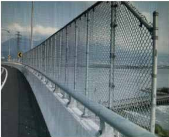
台 64 線快速道路八里 - 五股段 防護網和橋欄杆 (6)
