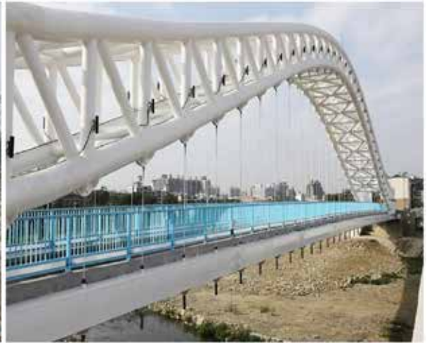
松竹五路～海天橋工程完工外觀 (9)
