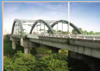
虎尾平和橋改建工程
