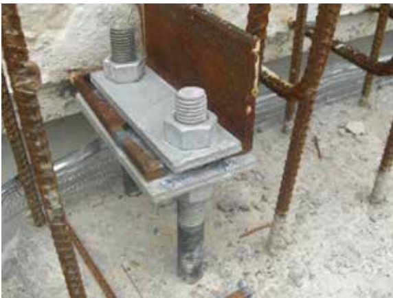
圖 13、機電工程架線基礎與骨架（熱浸鍍鋅）
