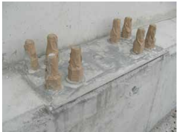
圖 13、機電工程架線基礎與骨架（熱浸鍍鋅）
