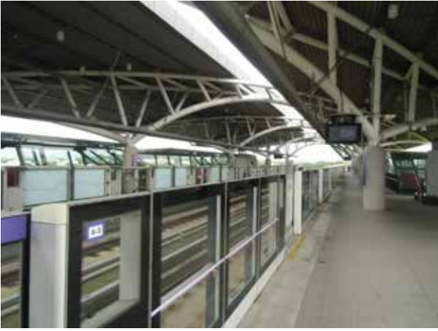
圖 14、機場捷運月台門
