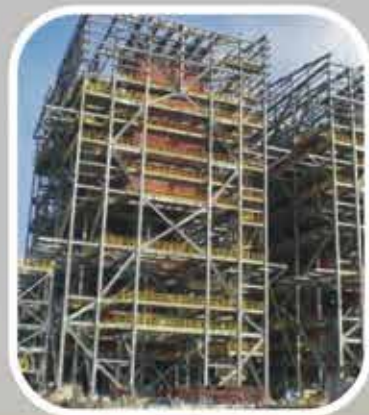
台塑德州案鍋爐鋼構工程
