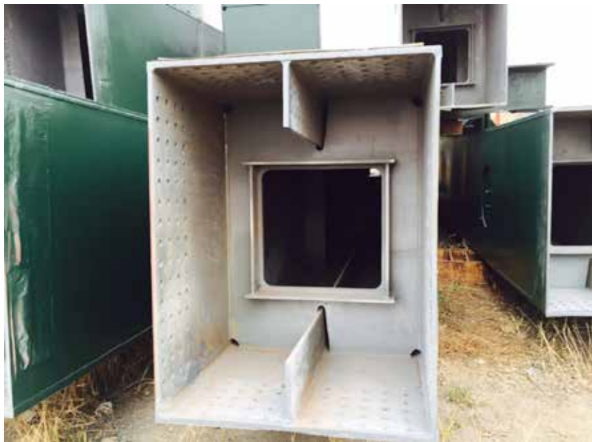
圖 8、平和橋熱浸鍍鋅鋼梁再塗裝
