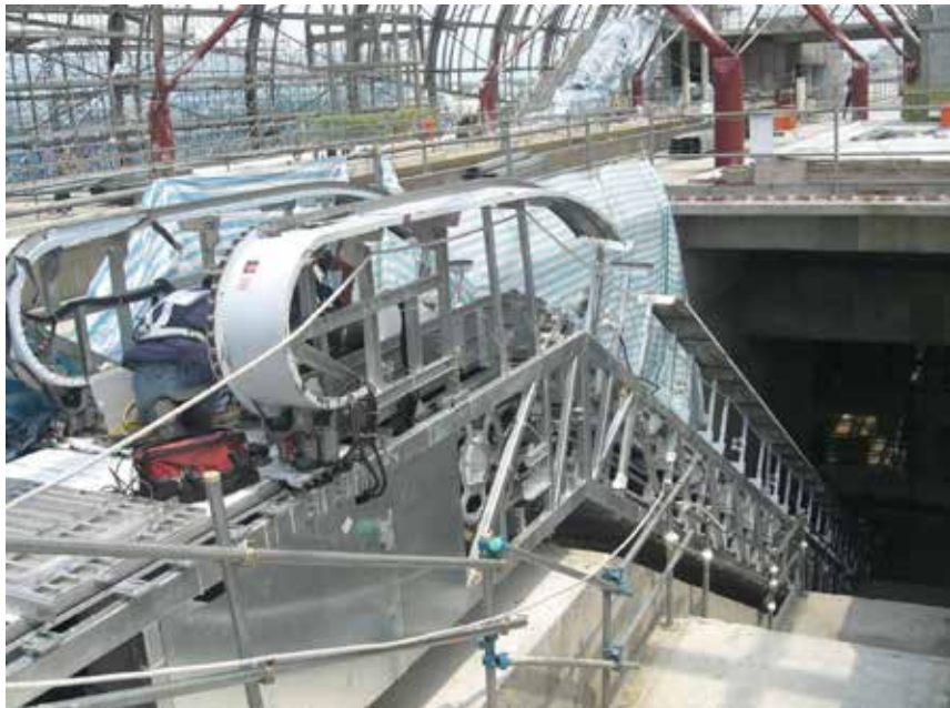
圖 10、新北產業園區站電扶梯熱浸鍍鋅骨架
