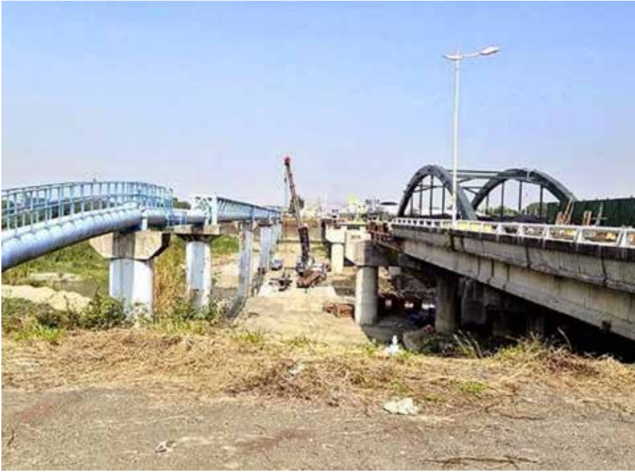
圖 9、平和橋半半施工，現場吊裝
