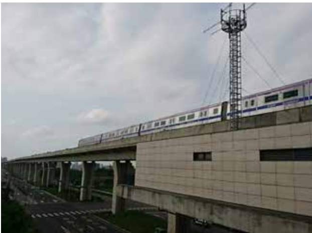
圖 16、機場捷運熱浸鍍鋅通訊塔
