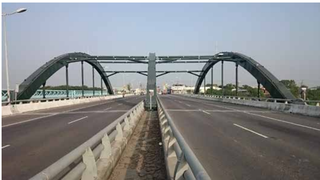
圖 12、平和橋完工啟用
