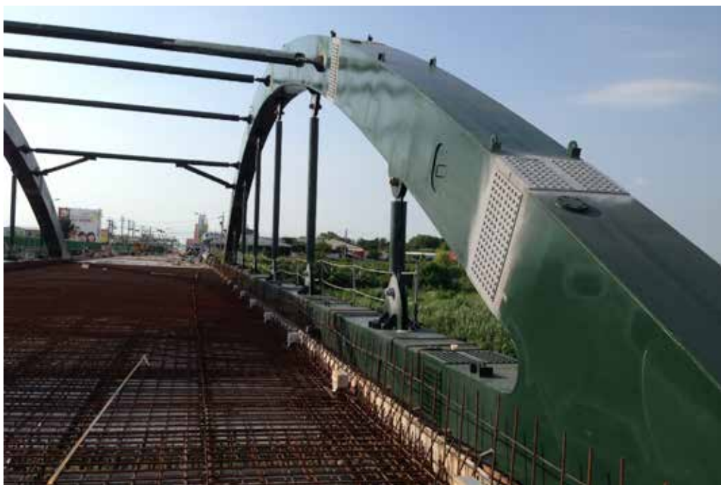
圖 11、平和橋橋面板鋼筋組立
