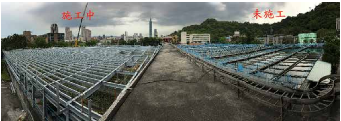
圖 7 施工與未施工比較
