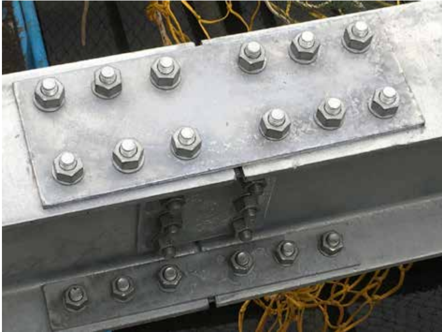
圖 6 使用的螺栓為 A325 熱浸鍍鋅高強度螺栓
