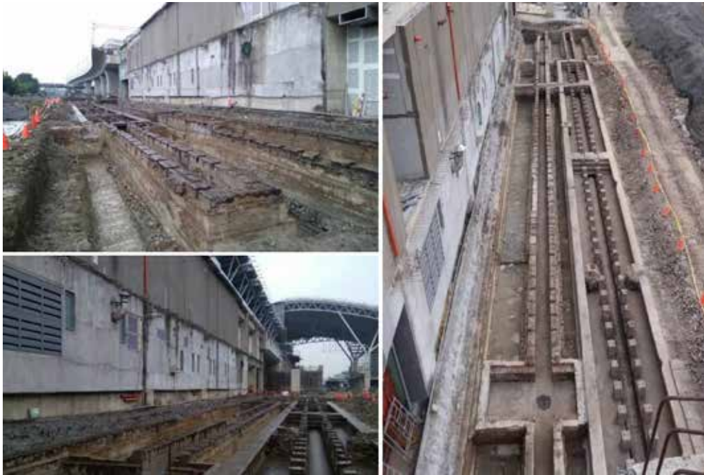
圖 31 第一階段站體與位於第二階段工址之遺構照片
