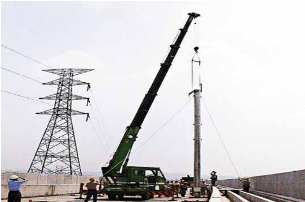
圖 3 台灣高速鐵路第 1 支熱浸鍍鋅鋼柱施工
