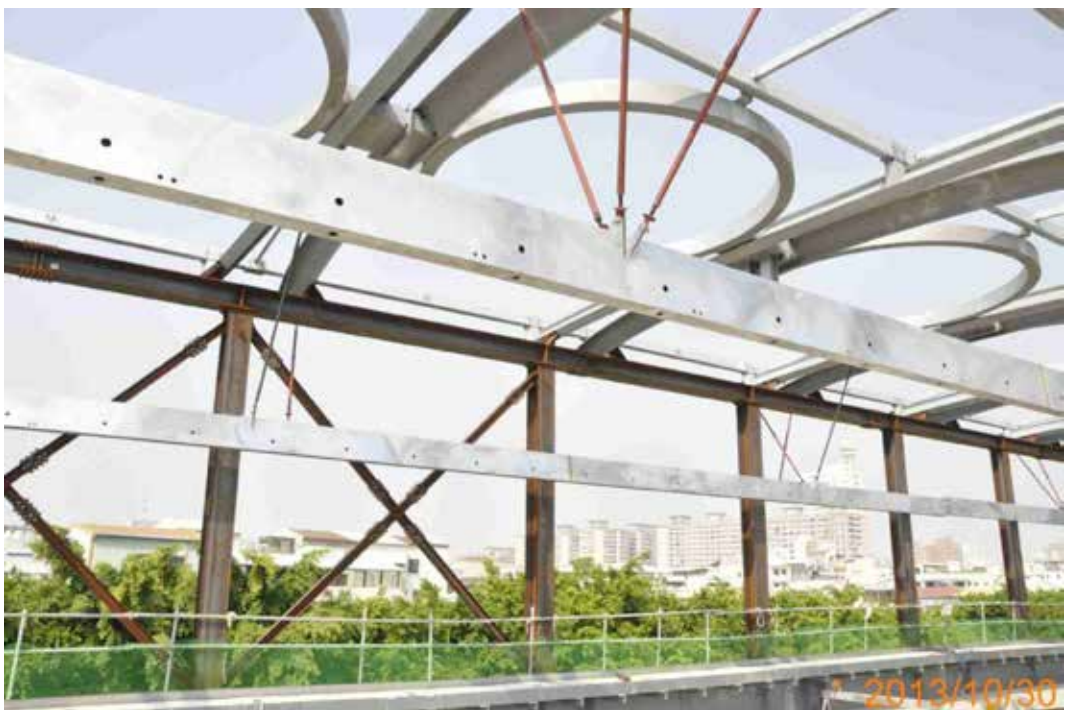
圖 35 岸壁式通勤車站近既有軌側熱浸鍍鋅雨棚採半半施工，遠側未鍍鋅部分則為暫撐鋼架(臺鍍科技(股)公司提供)
