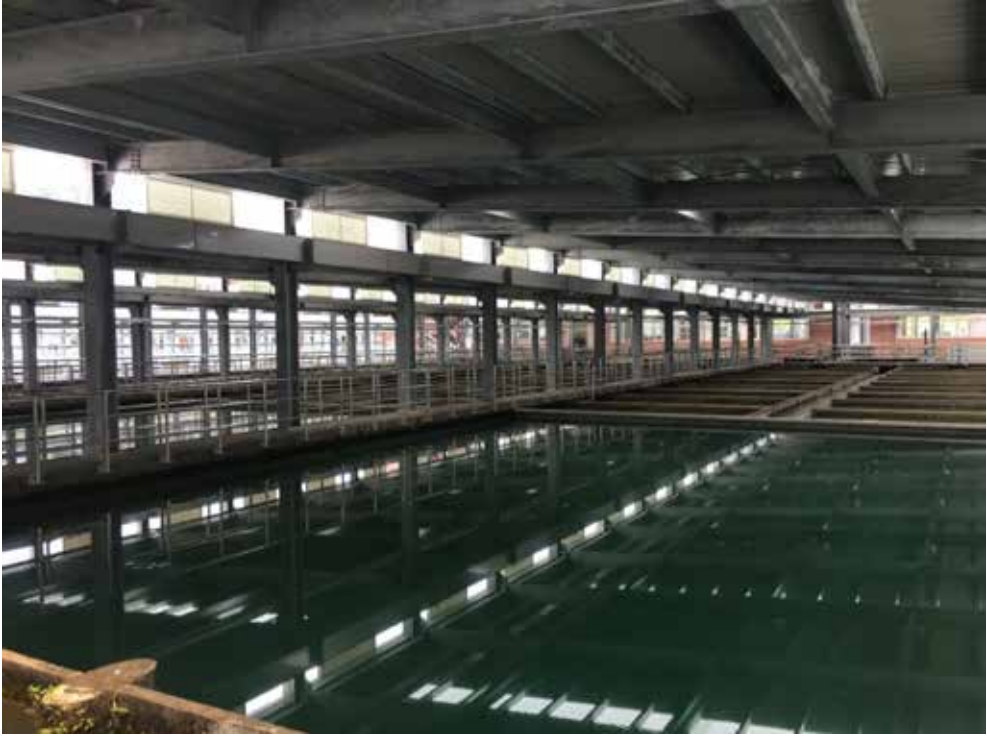
圖 8 屋頂加蓋完成，屋頂蓋板為熱浸鍍鋅鋁鋼板加烤漆處理
