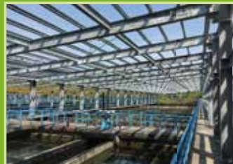
台北自來水長興淨水場池頂加蓋之鍍鋅工程
