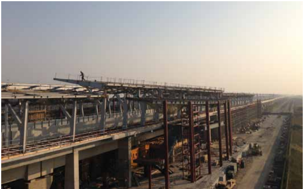
圖 9 高鐵候車站月台屋頂安裝工程
