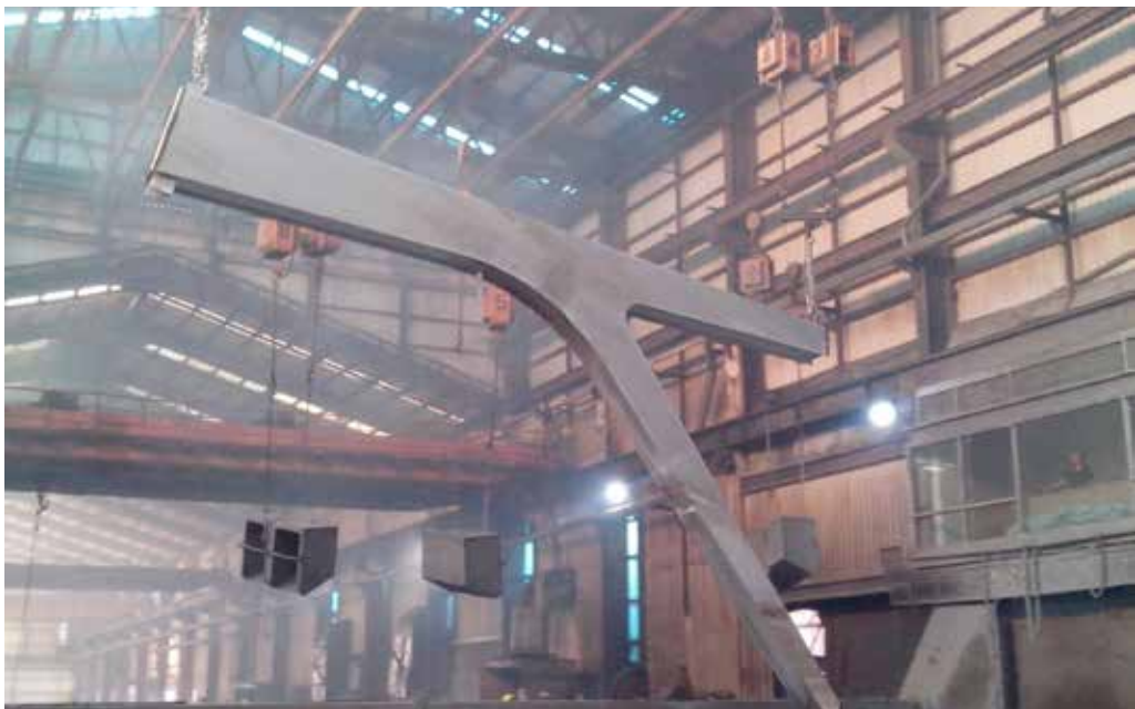
圖 8-1 箱梁 Y 型架 ~ 熱浸鍍鋅工場內鍍作情形
