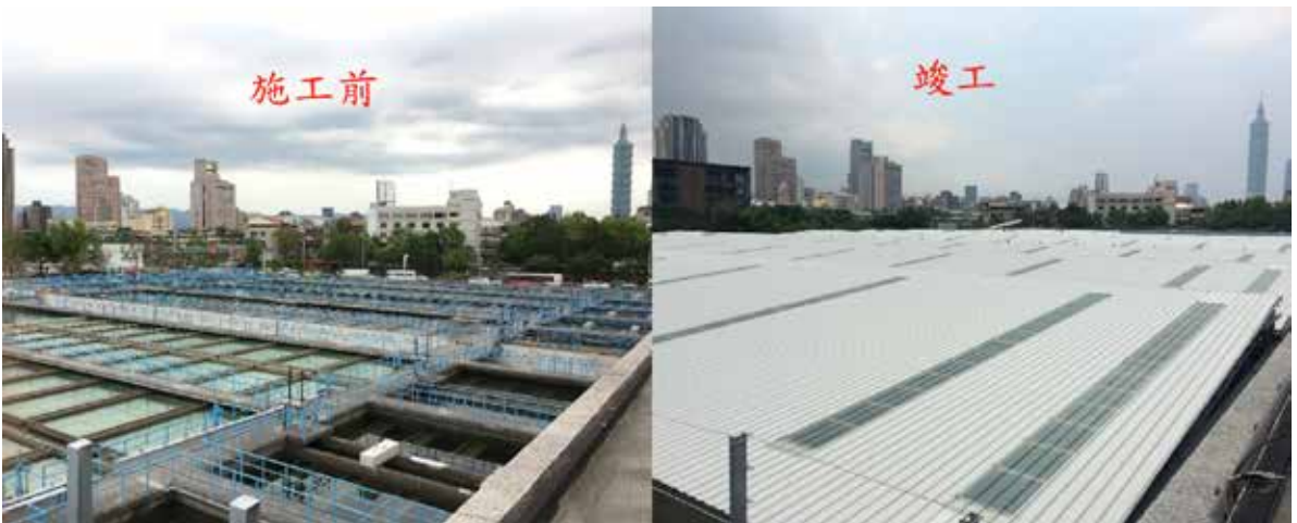
圖 9 施工前與竣工後比較圖
