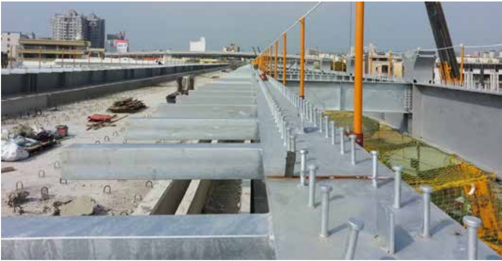
圖 36 岸壁式通勤車站月台梁 (臺鍍科技(股)公司提供)
