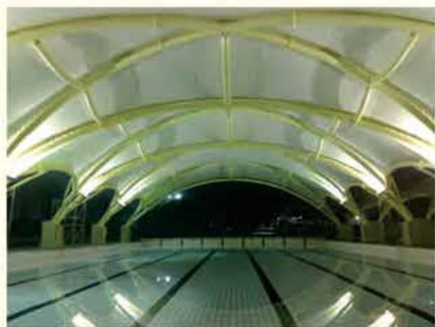
屏東科技大學游泳池
