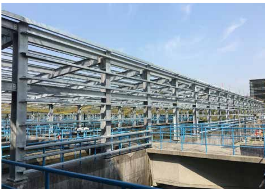
圖 5 鋼柱、橫梁安裝完成
