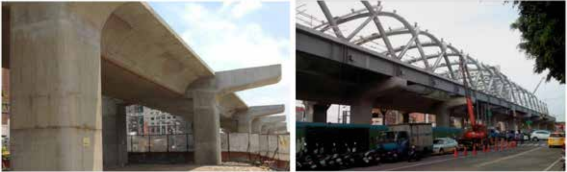
圖 8 橋梁標先行施築 (左)，車站標接續構築月台及雨棚 (右)
