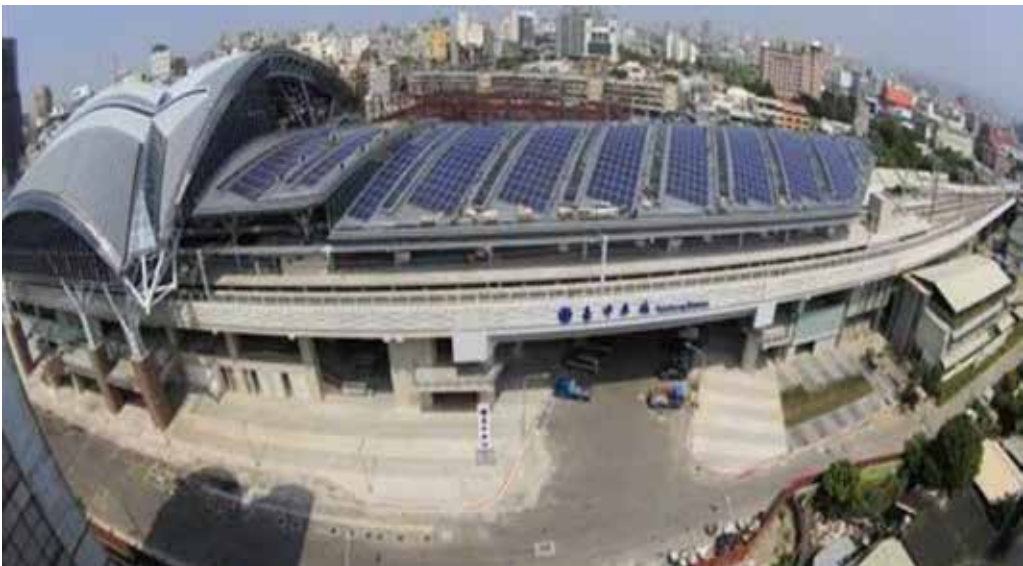
圖 28 大智路端景廣角照片（頂棚上裝設太陽能板；台灣世曦詹朝陽攝）
