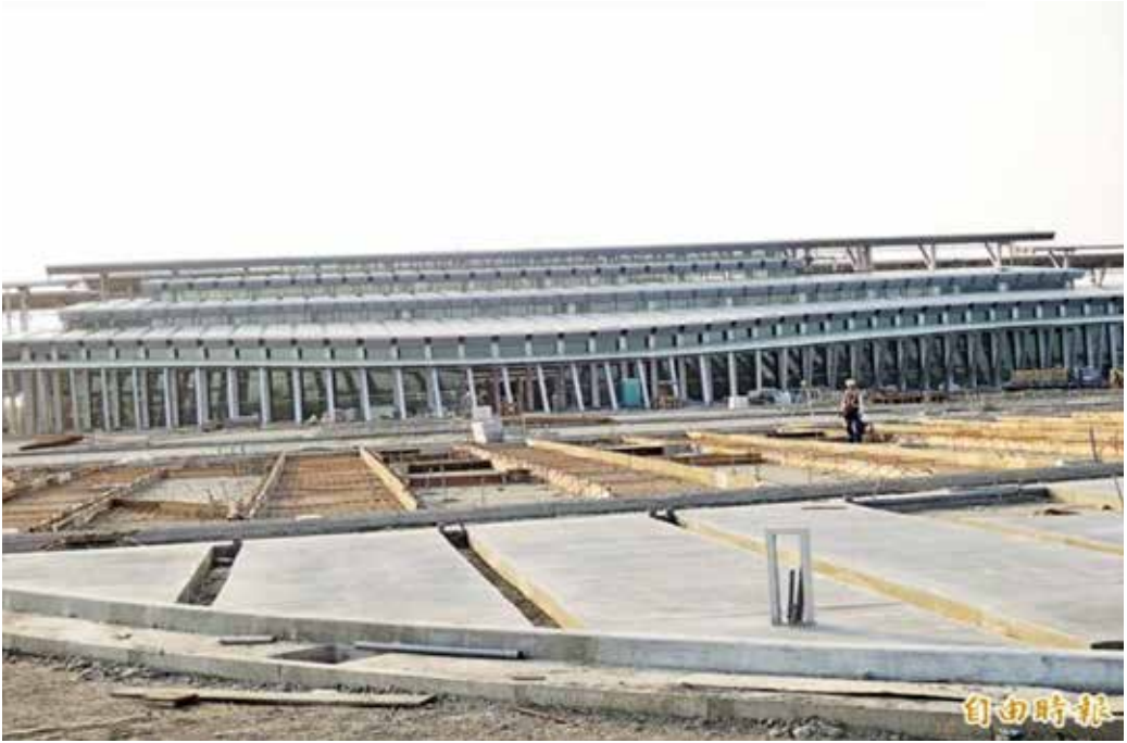
圖 5 主建物大廳屋頂鋼構 (苗栗後龍站)
