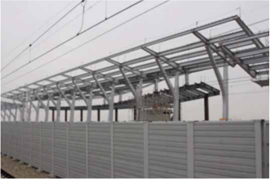
圖 8-2 高鐵車站屋頂雨遮鋼構安裝
