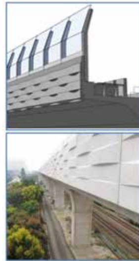
圖 5 隔音牆及已完成橋梁外觀
