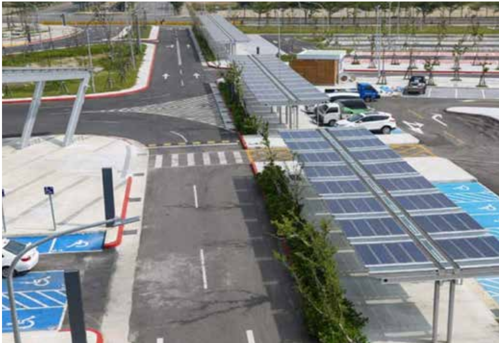
圖 10 太陽能供電板支架工程 (雲林虎尾站)
