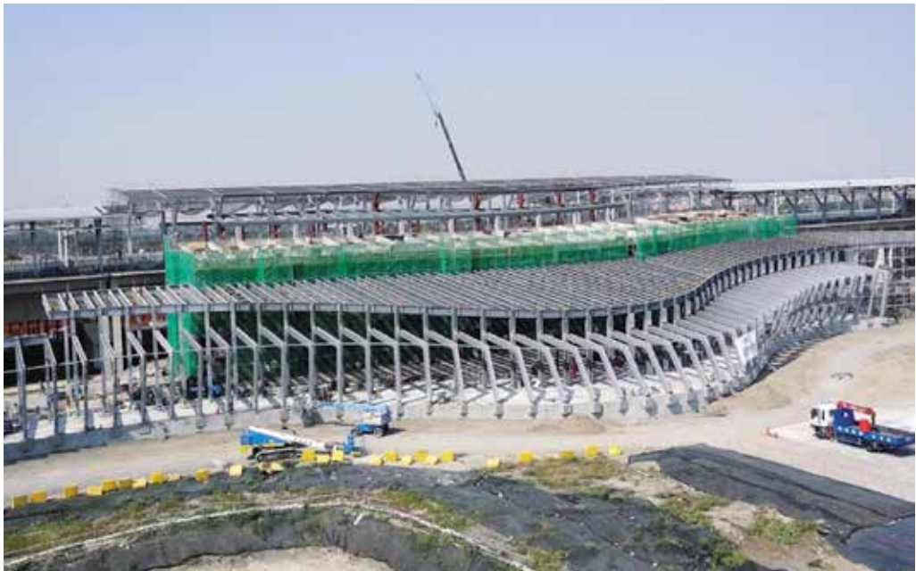
圖 6 高鐵站體主結構 (雲林虎尾站)
