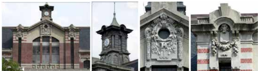
圖 23 正面山牆、塔尖及頂部裝飾
