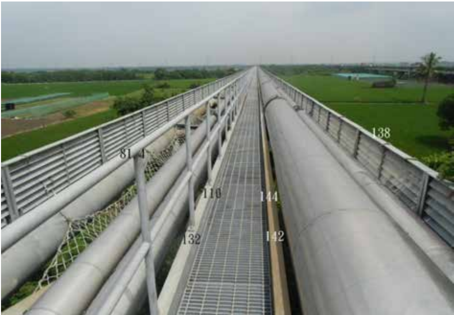
圖 5、南側第一跨步道 (圖上數字為平均膜厚, 單位為 \mu\text{m} )
