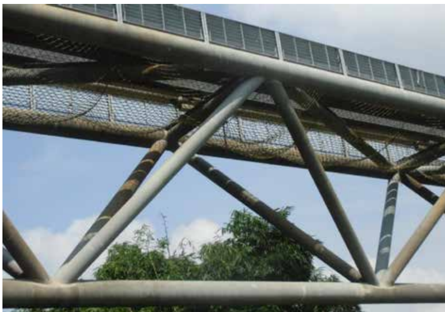
圖 12、管架橋南側近觀
