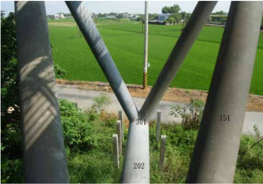
圖 8、北側第一跨端部
