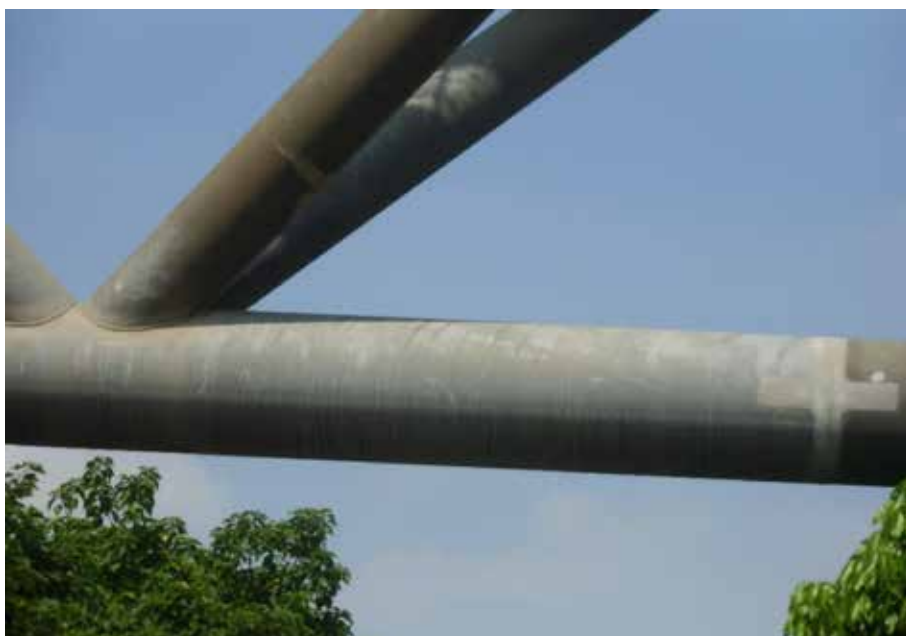
圖 13、管架橋鋼管與銲道外觀
