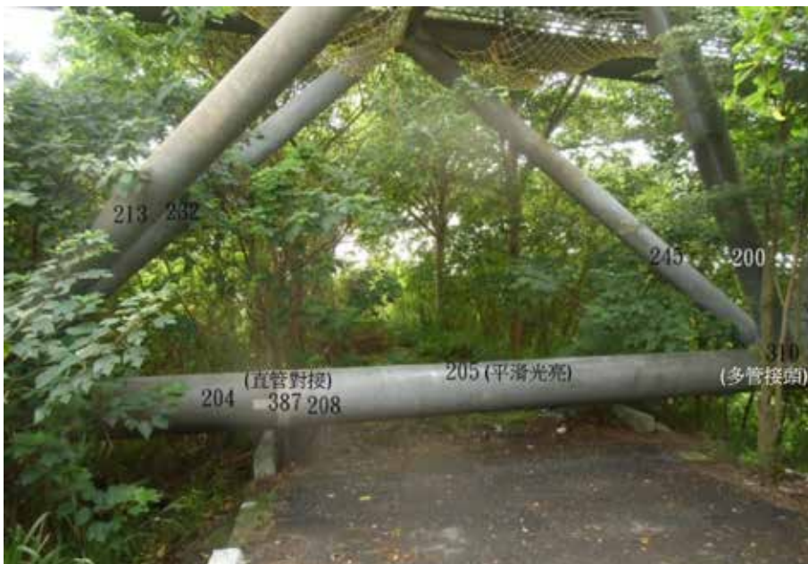
圖 7、南側第一跨 (堤防上方)
