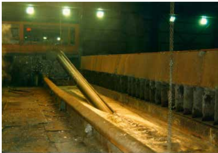
圖 2、管架橋鋼管熱浸鍍鋅
