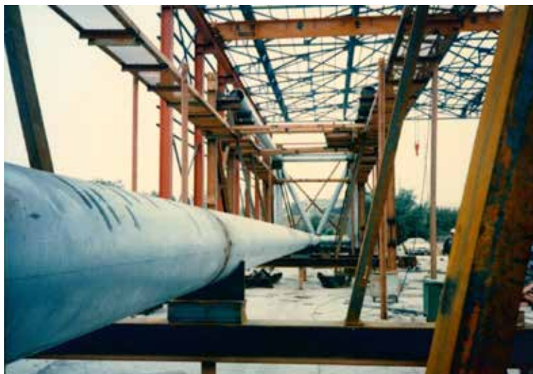
圖 3、熱浸鍍鋅鋼管銲接組成管架
