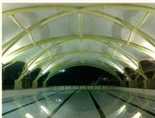
屏東科技大學游泳池
