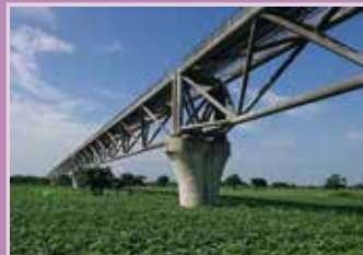
台灣中油濁水溪管架橋
