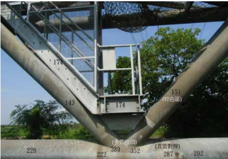
圖 9、北側第一跨 (堤防上方)
