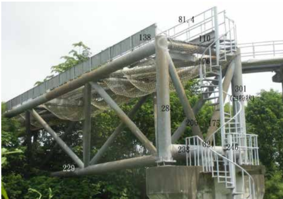
圖 6、南側第一跨端部 (圖上數字為平均膜厚，單位為 \mu\text{m} )
