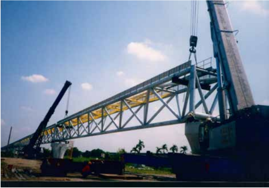
圖 4、熱浸鍍鋅管架橋吊裝
