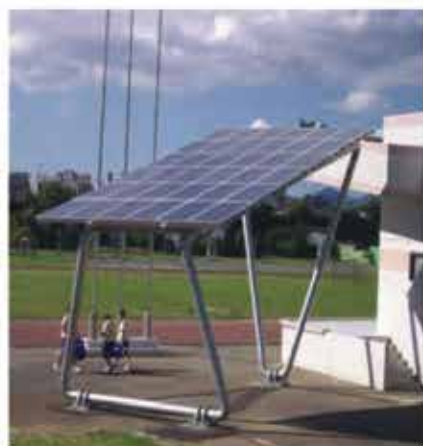
板橋國中太陽光電結構
