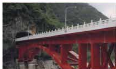
太魯閣砂卡礑溪鐵橋
