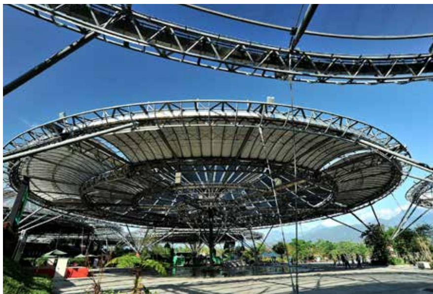
圖 4、每座傘架直徑約有十五米，採用熱浸鍍鋅防蝕
