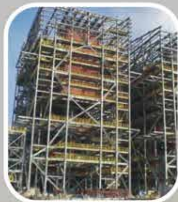
台塑德州案鍋爐鋼構工程
