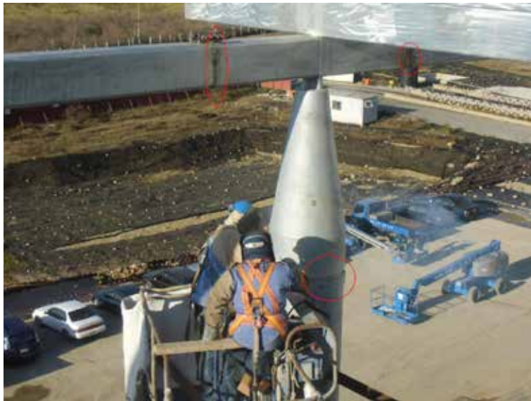
圖 7、熱浸鍍鋅鋼材於工地高空銲接
