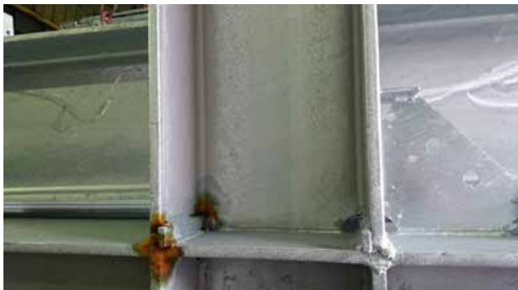
圖 6、背襯未密封銲接導致銹水流出污染周遭
