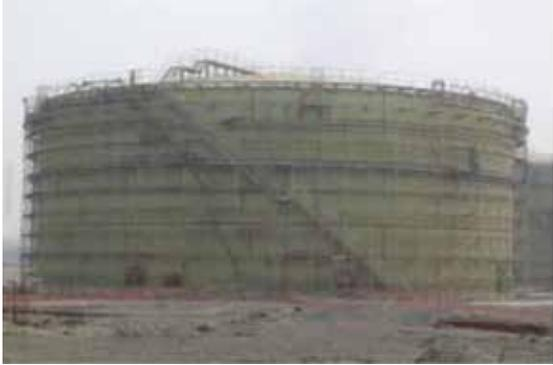
圖 10、熱浸鍍鋅桶槽施工
