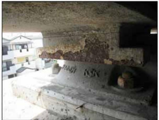
圖 12、梁端橋座的熱浸鍍鋅層劣化
