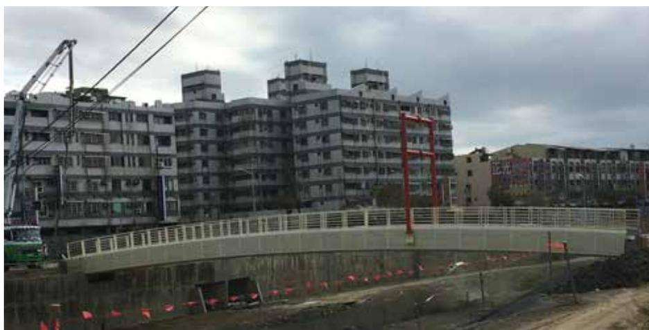
圖 4、鋼橋吊裝完成實景 (側面)
