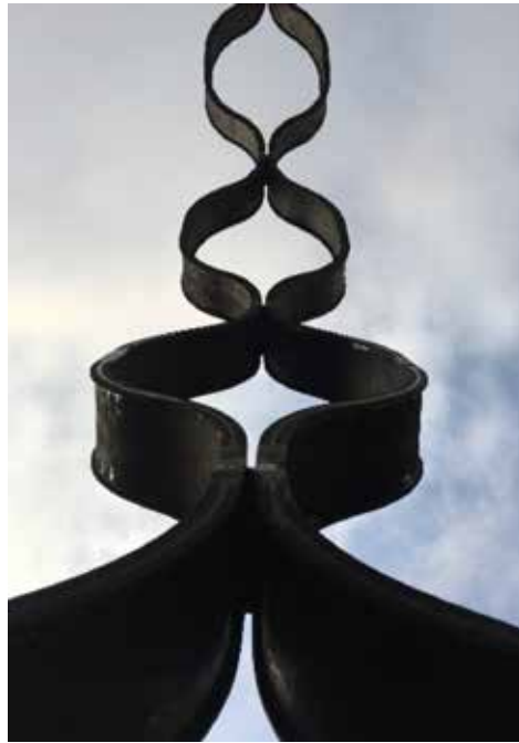
圖 7 熱浸鍍鋅後再經塗覆氟碳樹脂漆
