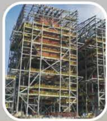
台塑德州案鍋爐鋼構工程
