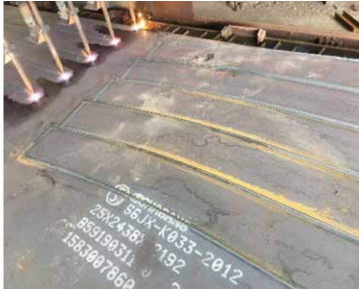
圖 2 鋼板 NC 火焰切割成一片一片
