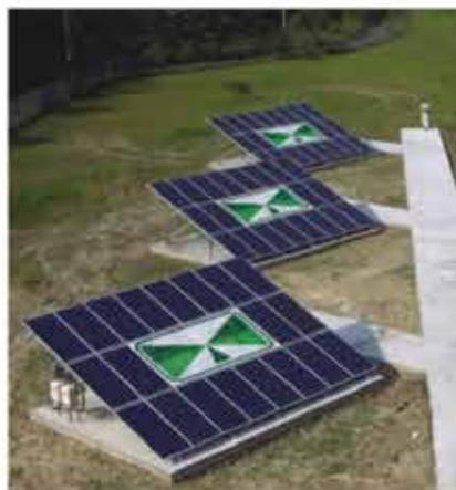
大型鋁合金太陽光電板架
