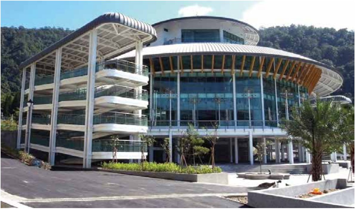
日月潭纜車鋼結構
