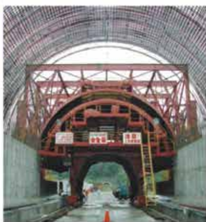
高鐵隧道內外鋼模台車
