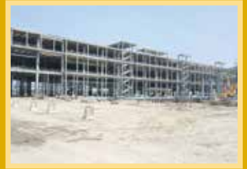
高雄機廠遷建潮州及原有廠址開發計畫 CL121標潮州機廠主體工程
