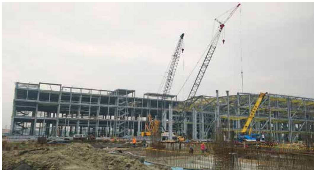
圖 2、主體修車廠、南區供應廠吊裝
