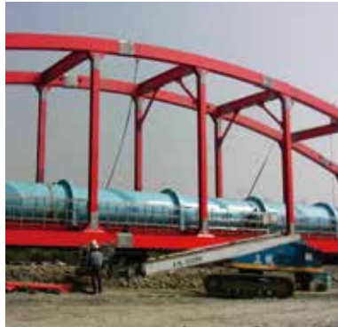
台中大肚溪水管橋
