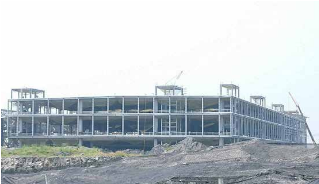
圖 1、主體修車廠、南區供應廠吊裝
