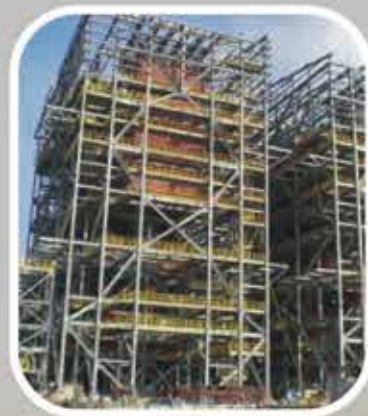
台塑德州案鍋爐鋼構工程
