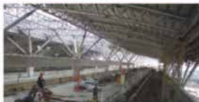
高鐵車站天花板
