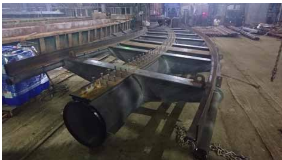
圖 2、主結構由 24 英吋 STK500 圓管銲組裝，寬度約 2.8m、長度約 18.3m 重量約 8 噸
