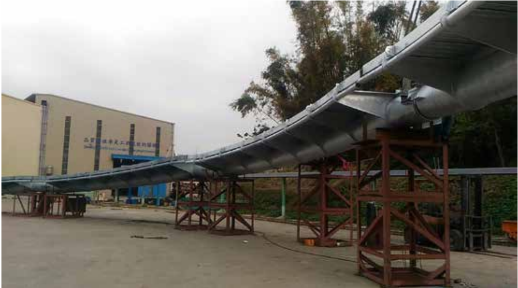
圖 8、熱浸鍍鋅後，陸橋預組立（一）
