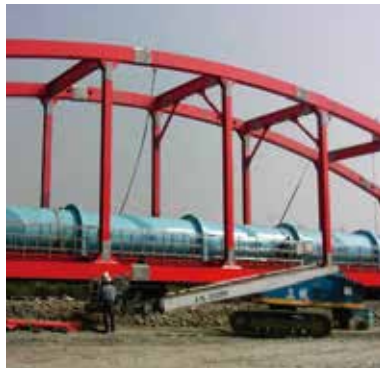
台中大肚溪水管橋
