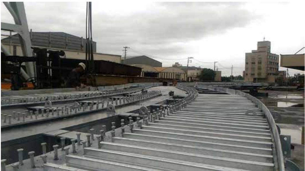
圖 9、熱浸鍍鋅後，陸橋預組立（二）
