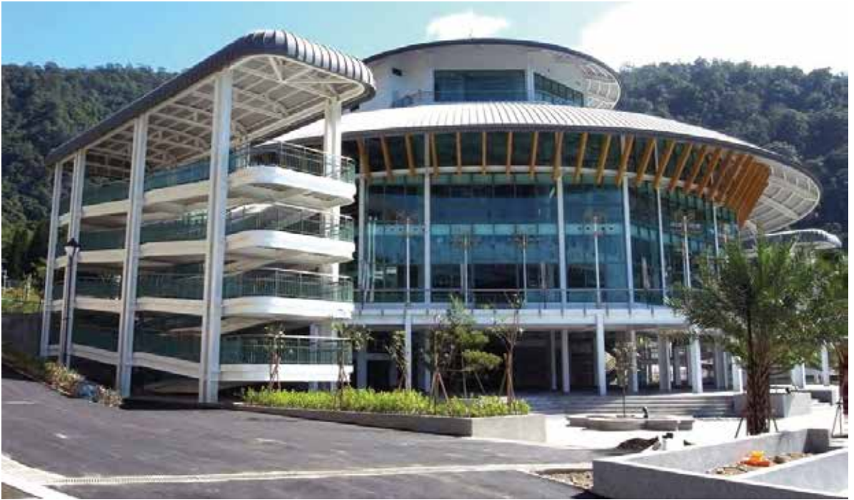
日月潭纜車鋼結構
