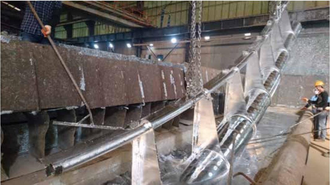
圖 7、主鋼管結構熱浸鍍鋅
