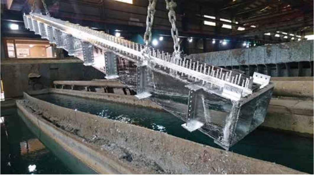
圖 6、箱梁結構熱浸鍍鋅
