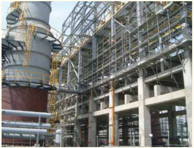
中油林園新六輕廠房結構
