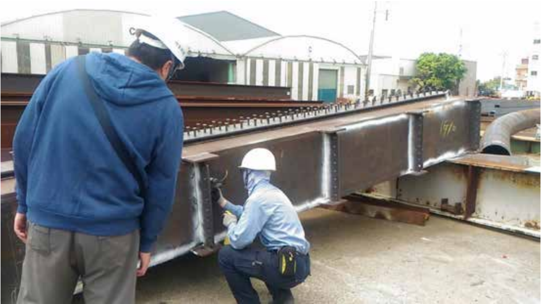
圖 5、銲道非破壞檢驗
