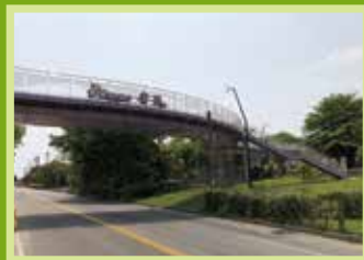
新北市省民公園旁環漢路側 增設跨堤陸橋工程
