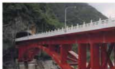
太魯閣砂卡檜溪鐵橋
