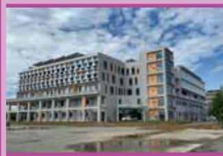
中研院南部院區興建工程太陽能架 工程名稱：中研院南部院區公共工程及第1棟 建築興建工程 專案管理單位：亞新工程顧問股份有限公司 設計單位：境向聯合建築師事務所 施工單位：根基營造股份有限公司 工程概要：公共工程及研究大樓I棟（含智慧溫室） 興建經費：新台幣1,618,840仟元 鍍鋅單位：臺鍍科技股份有限公司 鍍鋅鋼重：約400噸
