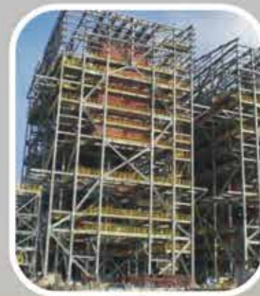
台塑德州案鍋爐鋼構工程
