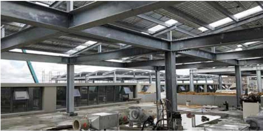
圖 5、興建工程安裝
