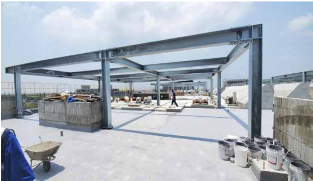
圖 3、興建工程安裝
