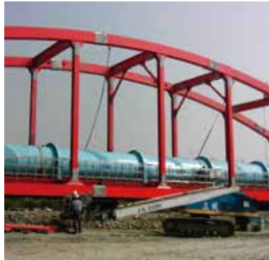
台中大肚溪水管橋
