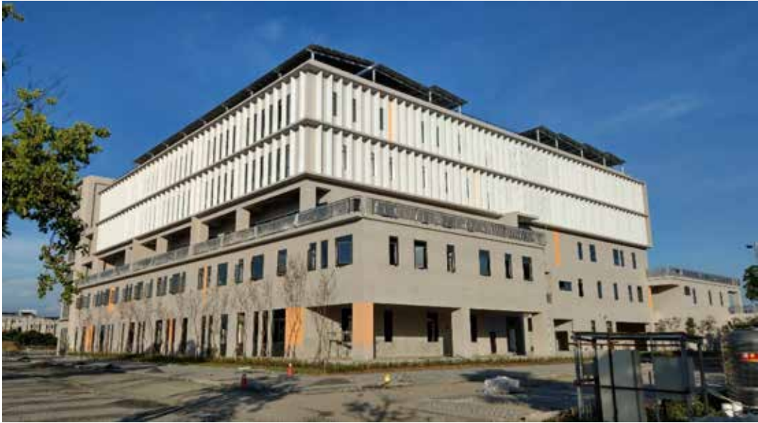
圖 7、興建工程安裝
