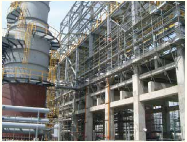
中油林園新六輕廠房結構
