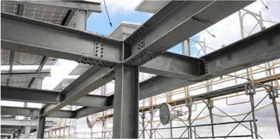
圖 4、興建工程安裝
