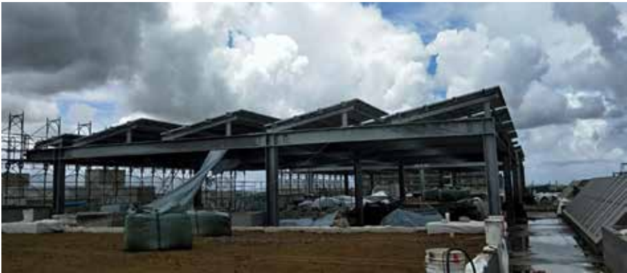
圖 6、興建工程安裝
