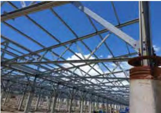
圖 9、角鋼斜撐、基礎螺絲及 PC 樁
