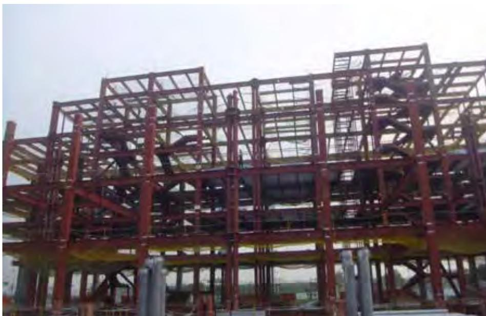
圖 9、鋼圓柱採熱浸鋅處理後，再以防火漆面漆塗裝而成(雙重防蝕)之 3
