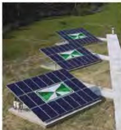
大型鋁合金太陽光電板架
