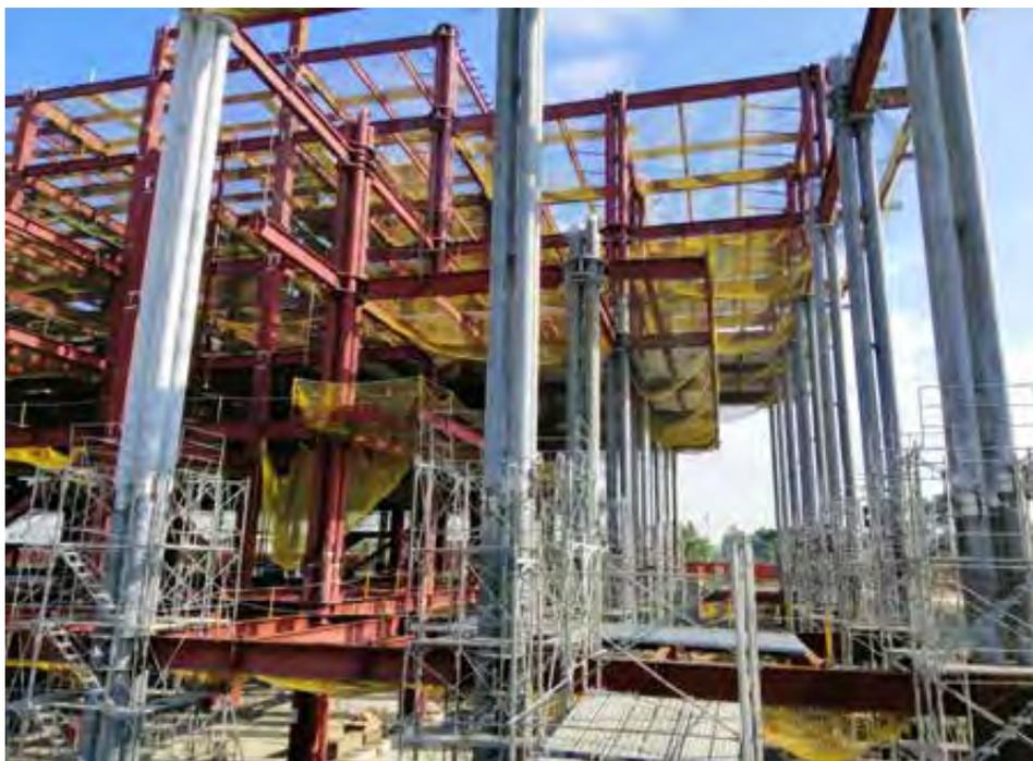
圖 8、鋼圓柱採熱浸鋅處理後，再以防火漆+面漆塗裝而成(雙重防蝕)之 2
