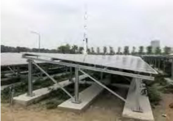
圖 1、輕型鋼柱體
