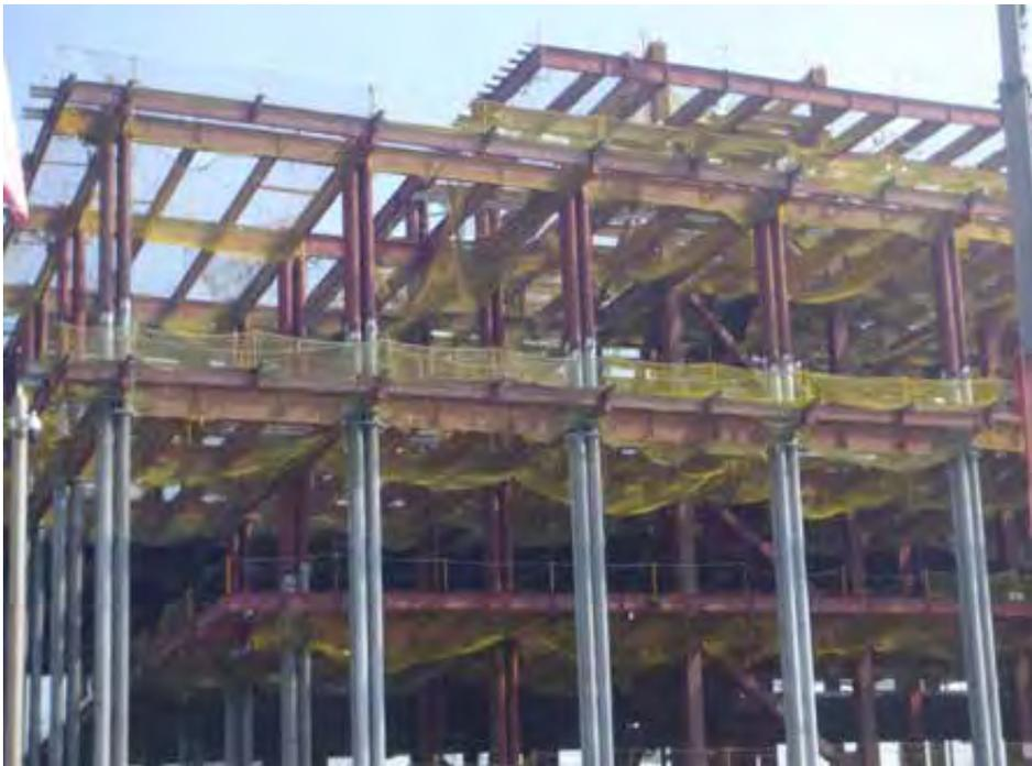
圖 7、鋼圓柱採熱浸鋅處理後，再以防火漆+面漆塗裝而成(雙重防蝕)之 1
