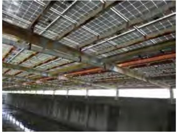
圖 18、桁條生鏽腐蝕
