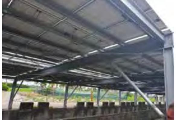
圖 8、鋼管斜撐及拉桿
