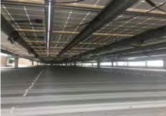
圖 7、輕型鋼桁條
