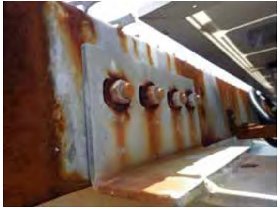
圖 16、螺栓華司電位差腐蝕
