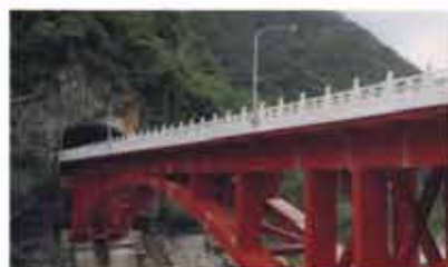
太魯閣砂卡礑溪鐵橋
