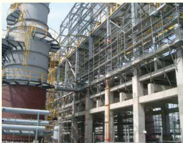
中油林園新六輕廠房結構
