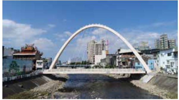
圖 2、斜垮單肋拱鋼拱橋設計
