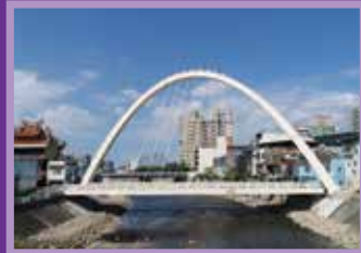
南通橋改建工程
