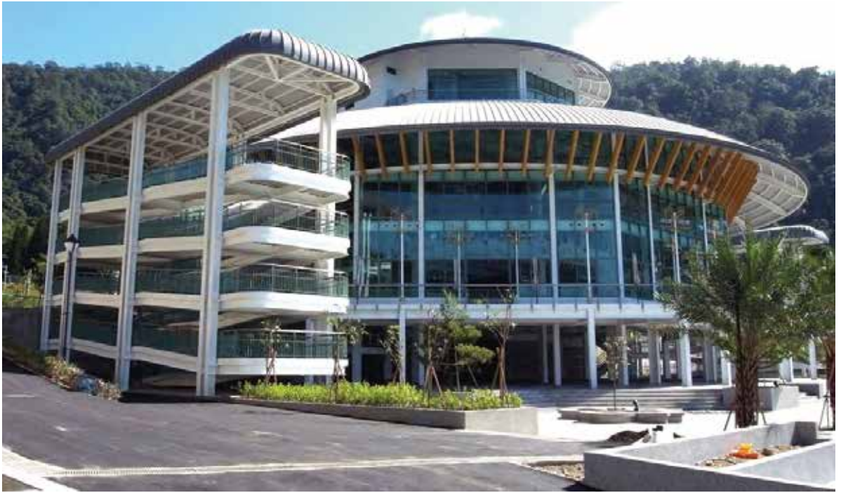
日月潭纜車鋼結構
