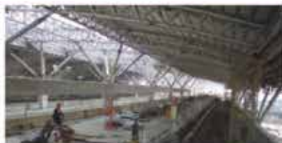
高鐵車站天花板
