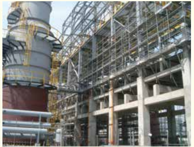
中油林園新六輕廠房結構
