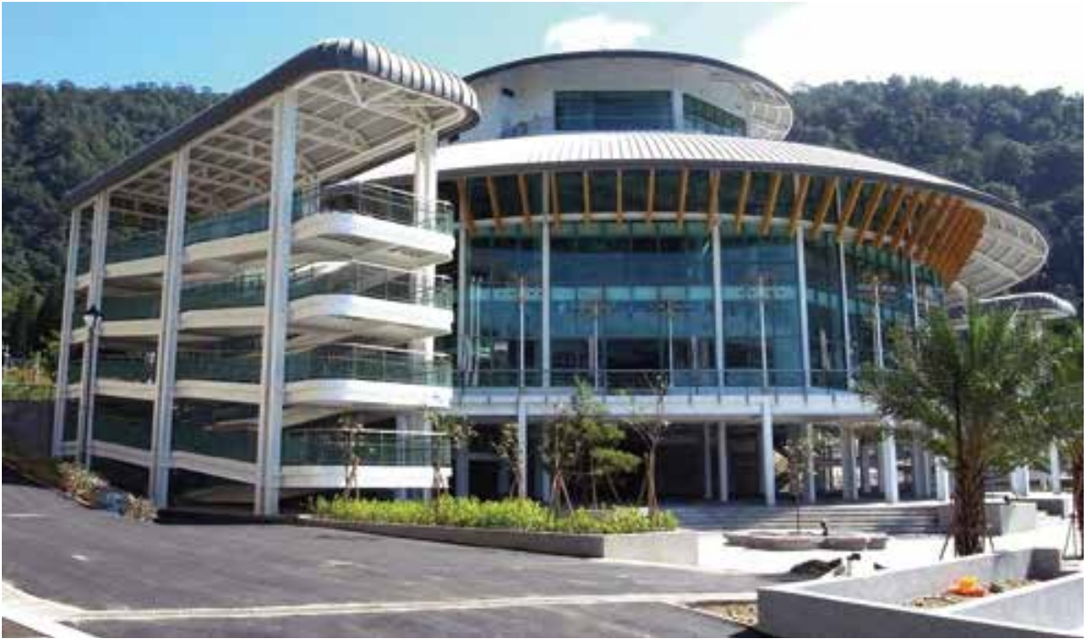
日月潭纜車鋼結構
