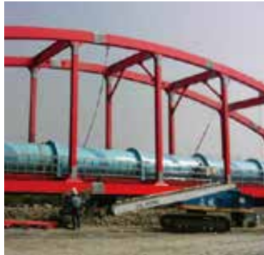
台中大肚溪水管橋
