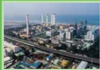
苗栗通霄發電廠~複循環發電機組設備廠房及相關設施更新改建計畫
