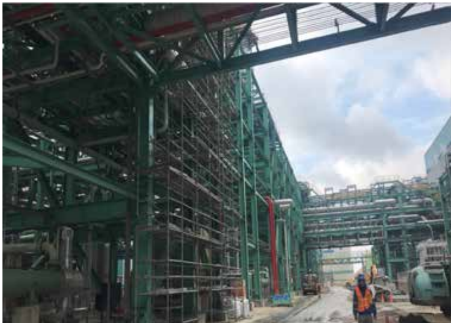
圖 9 天然氣輸送管架系統~2。
