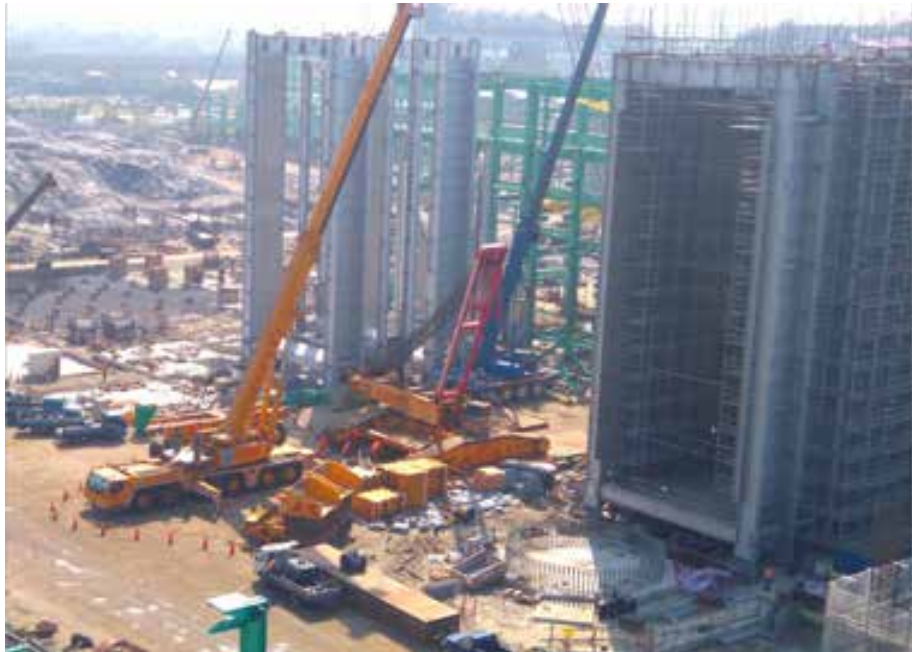
圖 4 廢熱回收鍋爐之爐管管排。
