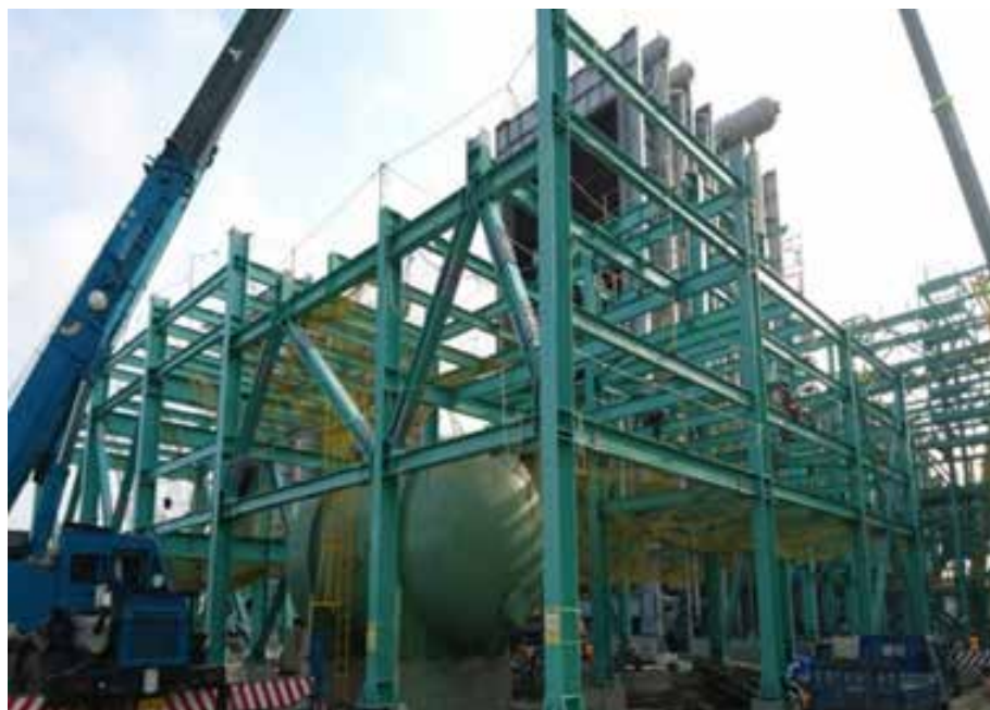
圖 6 GT 氣渦輪機廠房。
