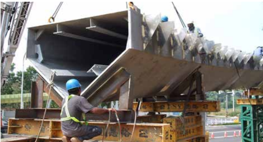
照片 4 箱體鍍鋅情形。
