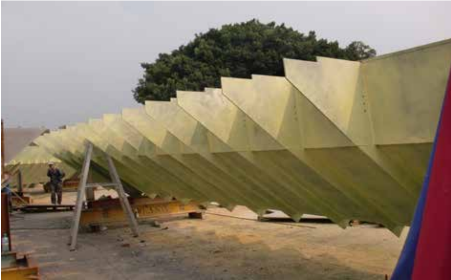
照片 7 工地現場噴塗介面漆。
