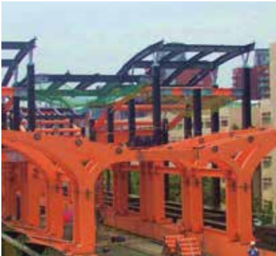
台北捷運內湖車站
