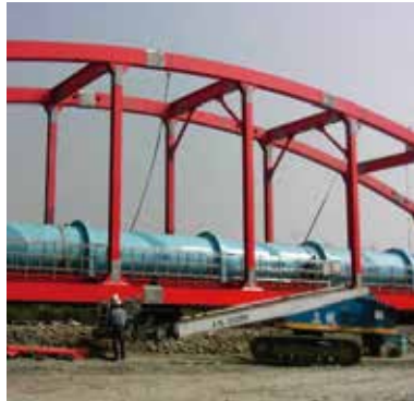
台中大肚溪水管橋
