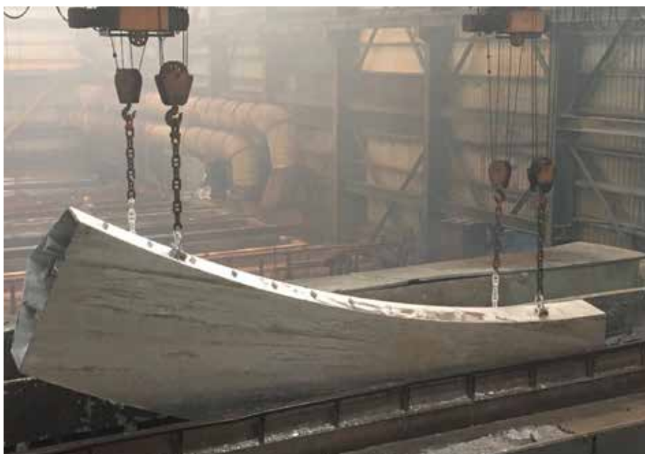
照片 5 工地旁焊接側板。
