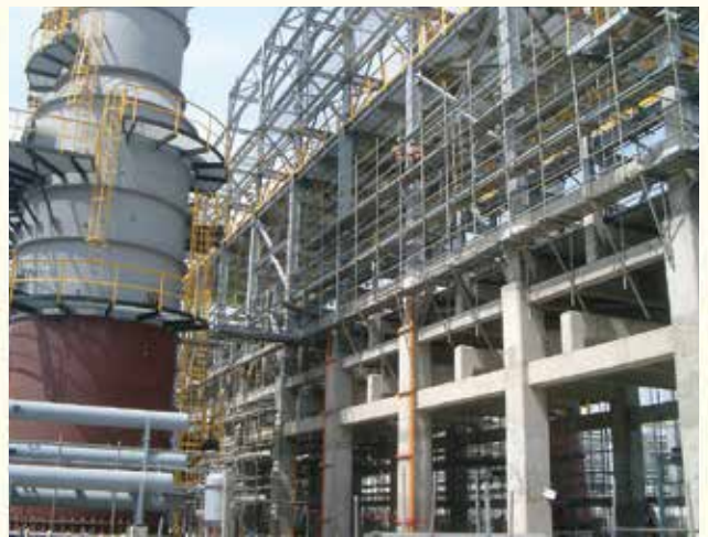
中油林園新六輕廠房結構
