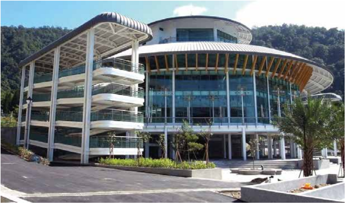
日月潭纜車鋼結構
