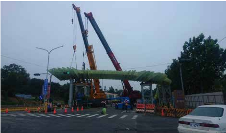
照片 8 工地旁橋體對接。
