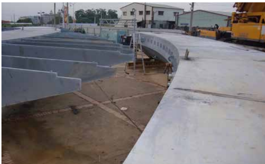
照片 6 工地旁橋體對接。
