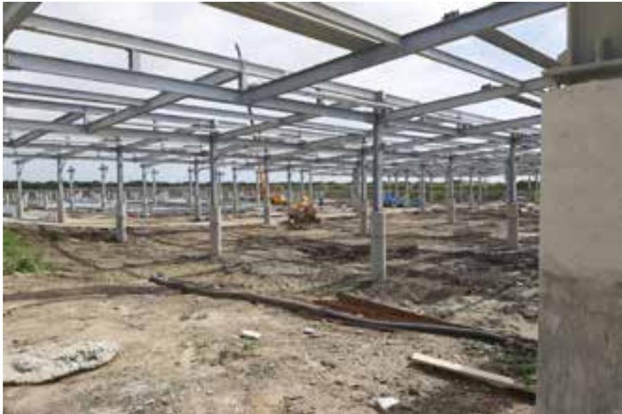
圖 2 H 型鋼柱及橫梁安裝狀況。
