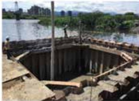
圖 10 橋墩施工圍堰外圍澆灌 CLSM。
