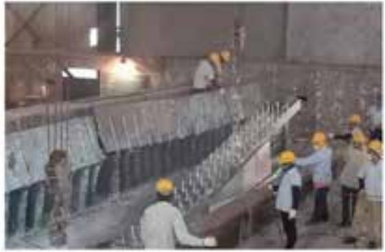
圖 14 鋼橋熱浸鍍鋅作業。
