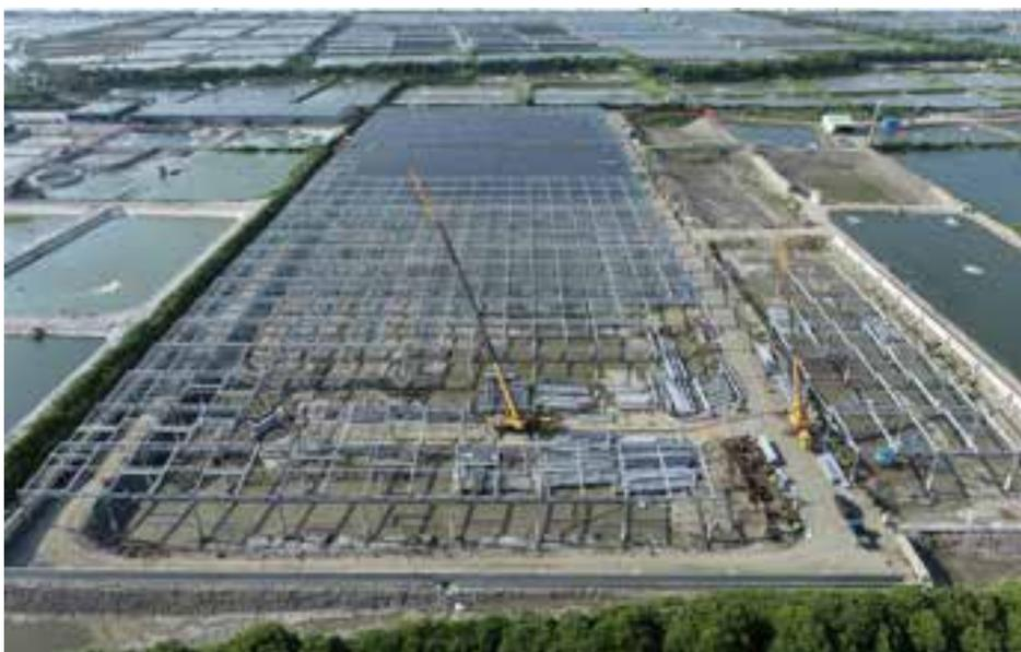
圖 3 H 型鋼柱及橫梁吊裝近完工。
