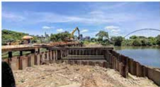
圖 9 橋墩施工圍堰打設。
