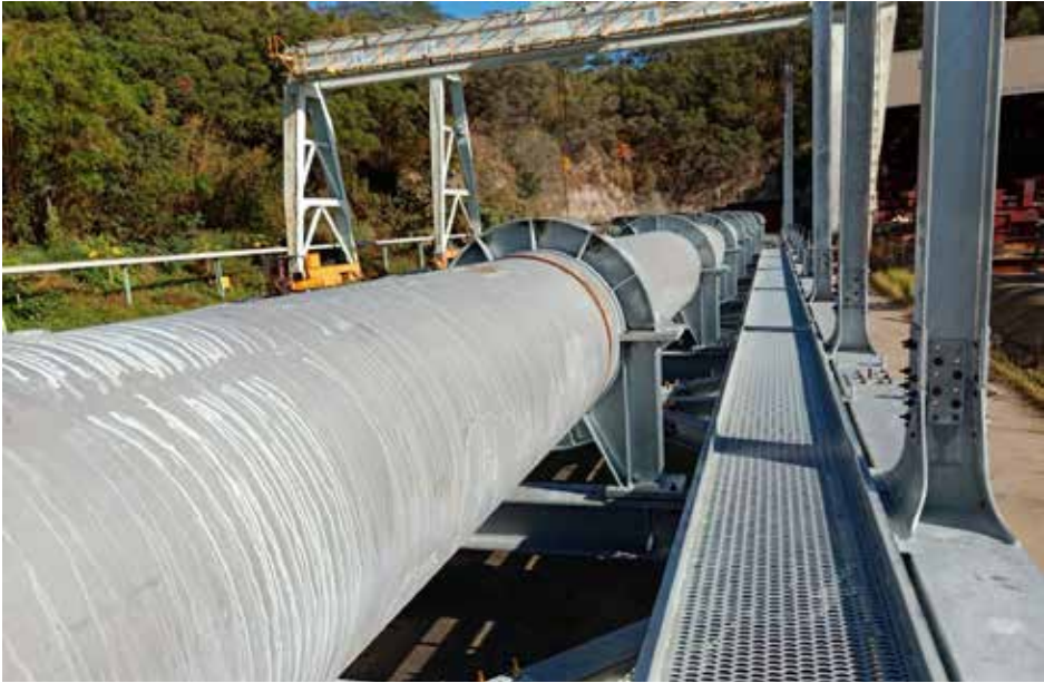
圖 11 水管橋預組立 (2)。
