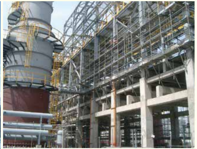
中油林園新六輕廠房結構
