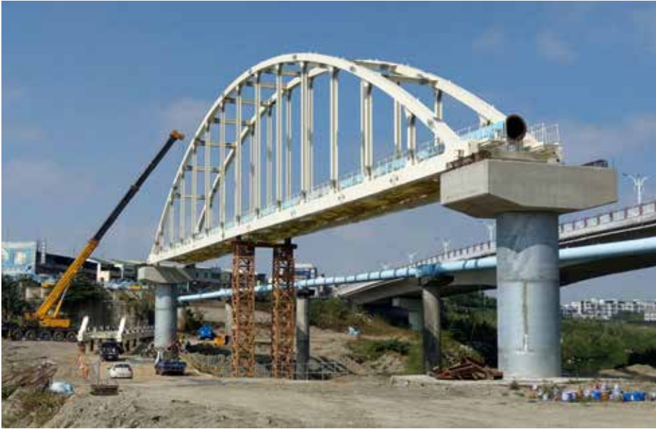
圖 14 現場吊裝作業。
