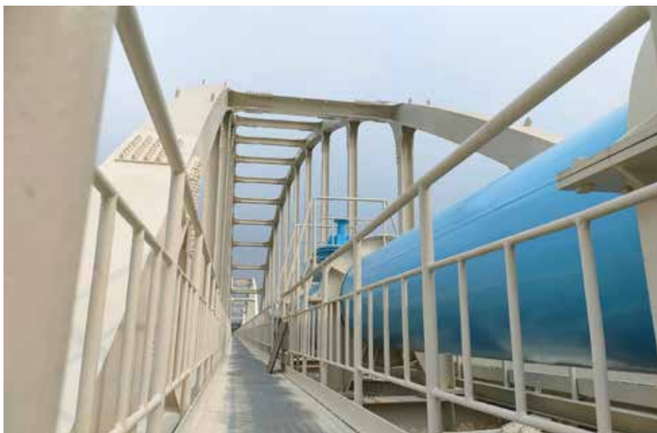
圖 16 維修步道、欄杆。
