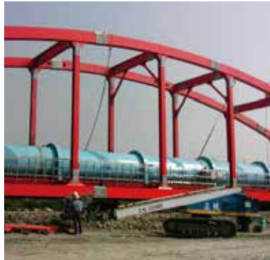
台中大肚溪水管橋
