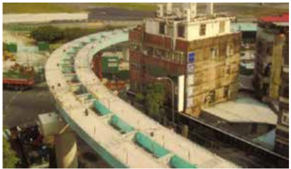
圖 24 施工中現況圖。
