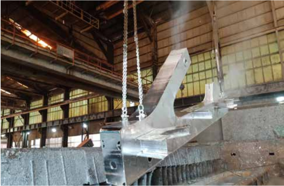
圖 3 箱型梁熱浸鍍鋅。
