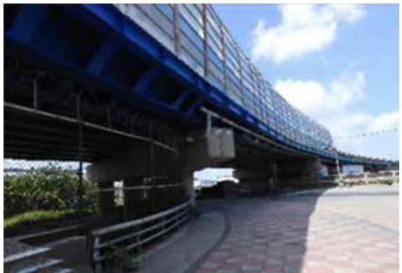
圖 12 引橋目前正在作油漆維護工作。
