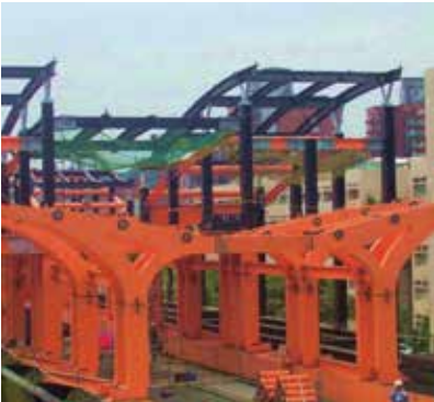
台北捷運內湖車站
