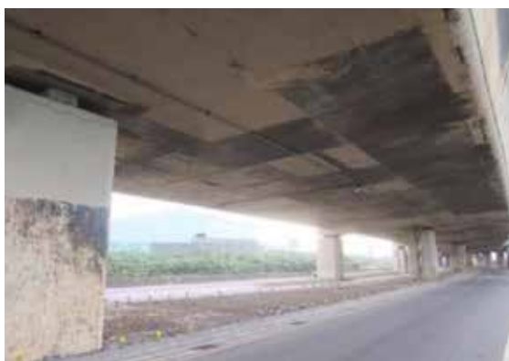
圖 19 上部結構工作組立筋鋼筋銹蝕混凝土保護層剝落。
