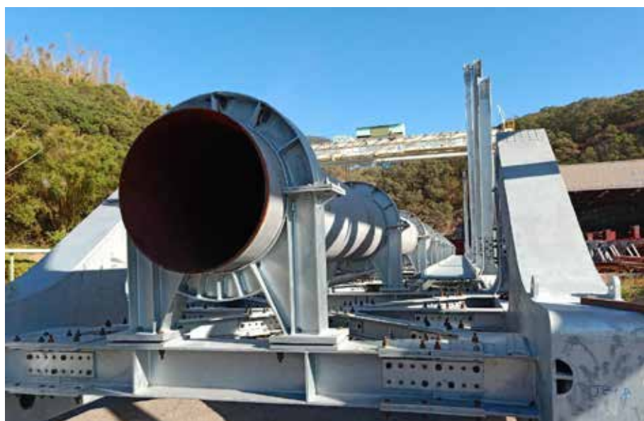
圖 10 水管橋預組立 (1)。
