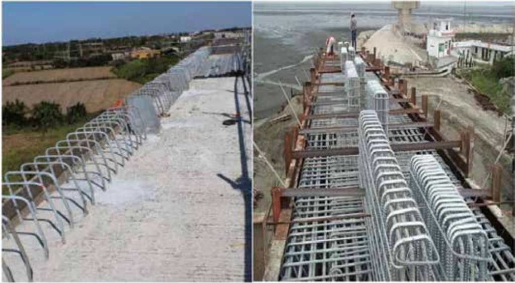
圖 31 熱浸鍍鋅鋼筋。
