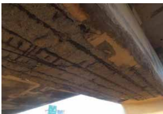
圖 19 上部結構工作組立筋鋼筋銹蝕混凝土保護層剝落。
