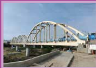
嘉義縣民雄鄉華興橋汰換管線工程
