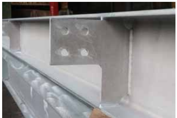
圖 17 銳緣採用熱浸鍍鋅。
