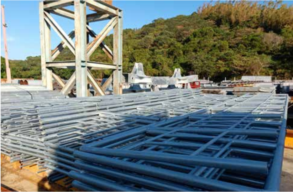
圖 7 維修走道欄杆。
