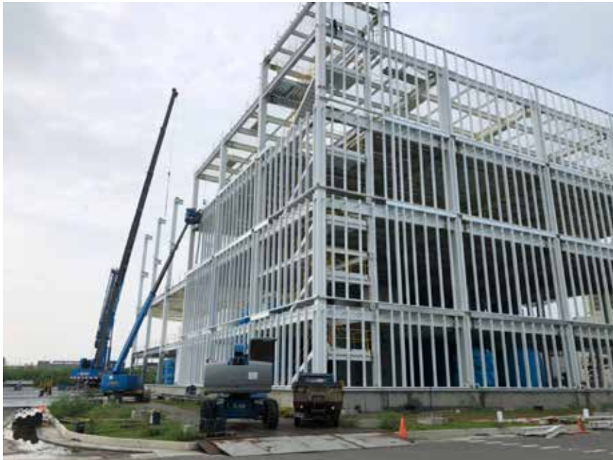
圖 12 長春彰濱二廠 EHP 雙氧水廠房鋼構 -10。
