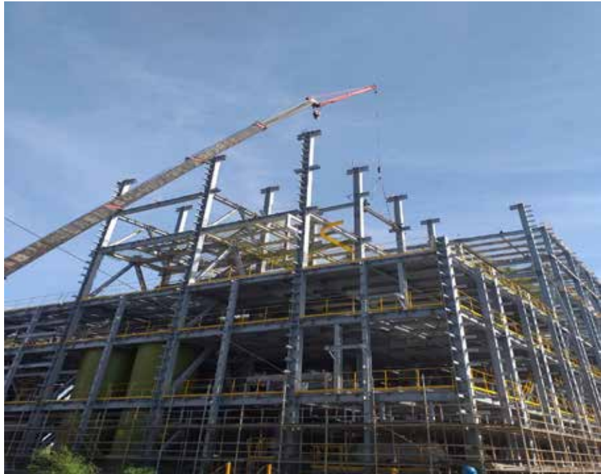
圖 11 長春彰濱二廠 EHP 雙氧水廠房鋼構 -9。
