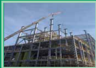
長春彰濱二廠EHP雙氧水廠房鋼構熱浸鋅工程
