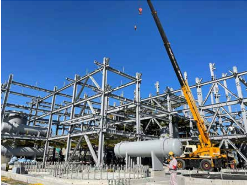
圖 6 長春彰濱二廠 EHP 雙氧水廠房鋼構 -4。
