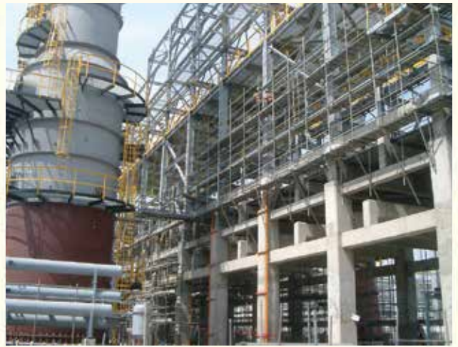
中油林園新六輕廠房結構
