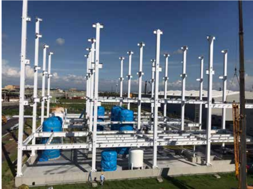
圖 4 長春彰濱二廠 EHP 雙氧水廠房鋼構 -2。
