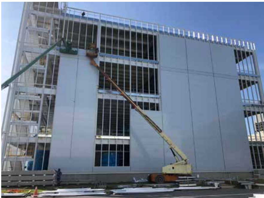
圖 13 長春彰濱二廠 EHP 雙氧水廠房鋼構 -11。
