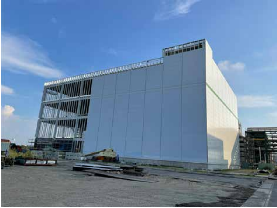
圖 14 長春彰濱二廠 EHP 雙氧水廠房鋼構 -12。
