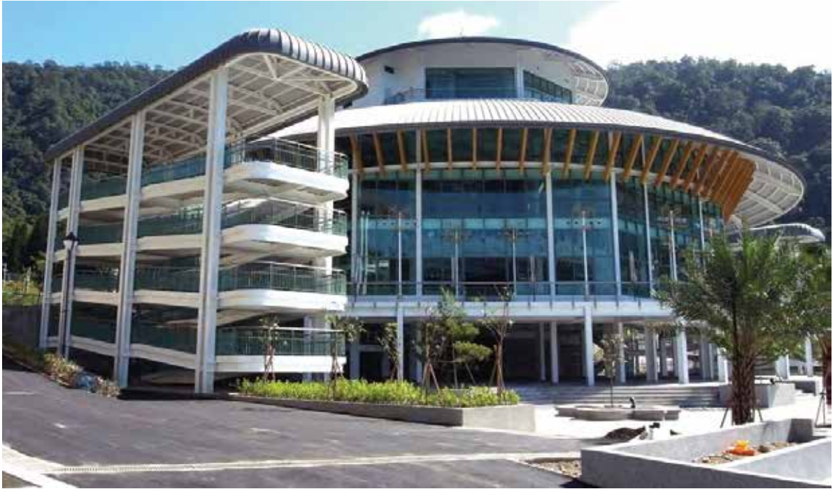
日月潭纜車鋼結構
