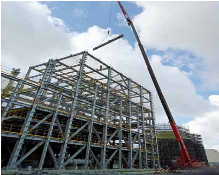
圖 9 長春彰濱二廠 EHP 雙氧水廠房鋼構 -7。
