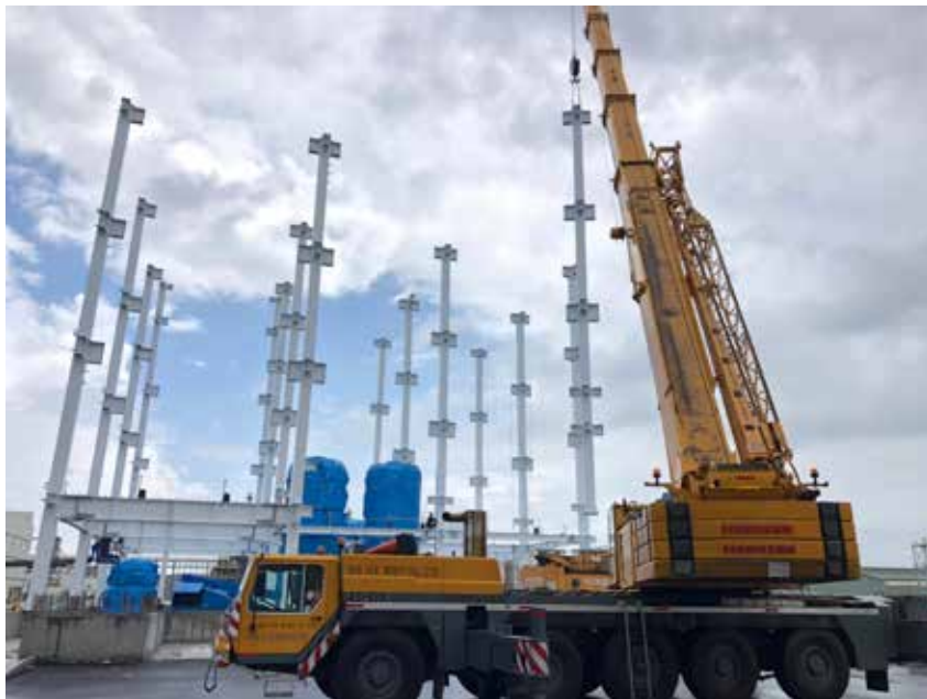
圖 3 長春彰濱二廠 EHP 雙氧水廠房鋼構 -1。
