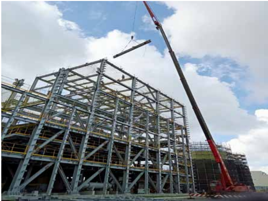
圖 7 長春彰濱二廠 EHP 雙氧水廠房鋼構 -5。
