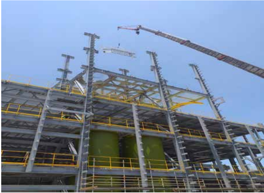
圖 10 長春彰濱二廠 EHP 雙氧水廠房鋼構 -8。
