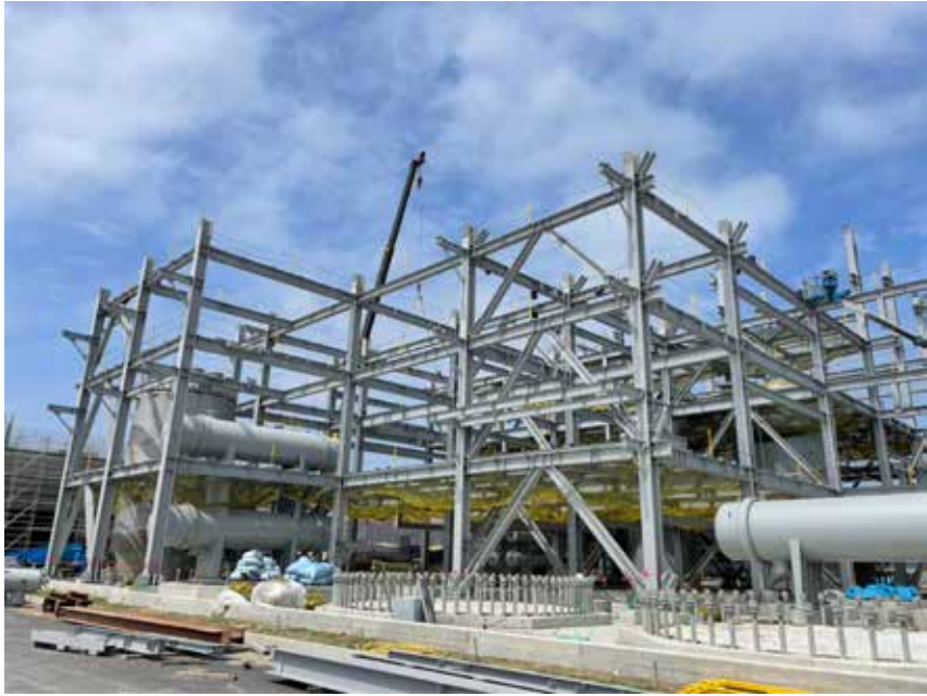
圖 8 長春彰濱二廠 EHP 雙氧水廠房鋼構 -6。
