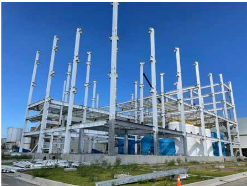
圖 5 長春彰濱二廠 EHP 雙氧水廠房鋼構 -3。
